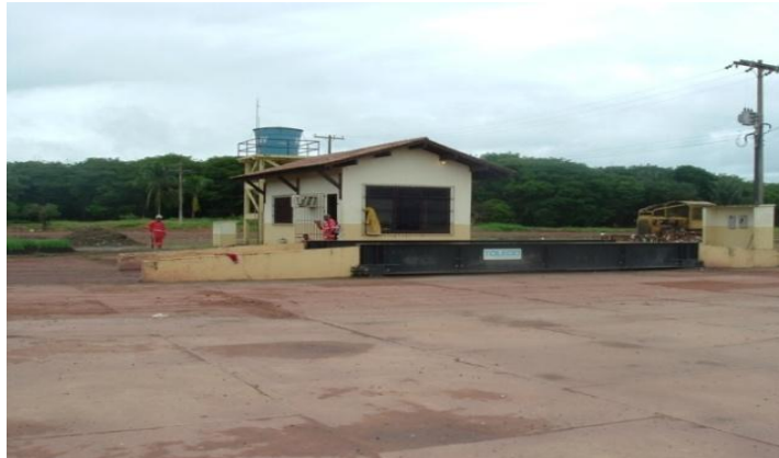
Figura 6: Futuro Aterro Sanitário de Macapá (a) Fonte: PMM (2009)
