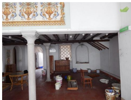
Figura 110 - Interior do Edifício
