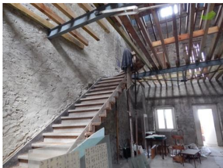
Figura 109 - Interior do Edifício
