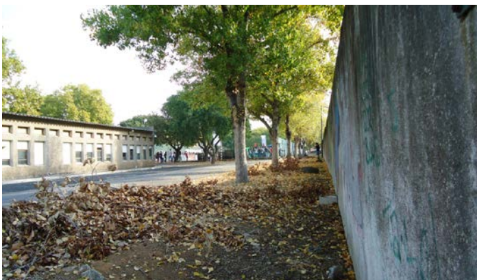
Fotografia 14: Muro que divide a rua Guilherme Salgado da escola
