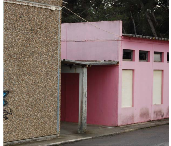
Fotografia 11: Pavilhões da fachada Norte
