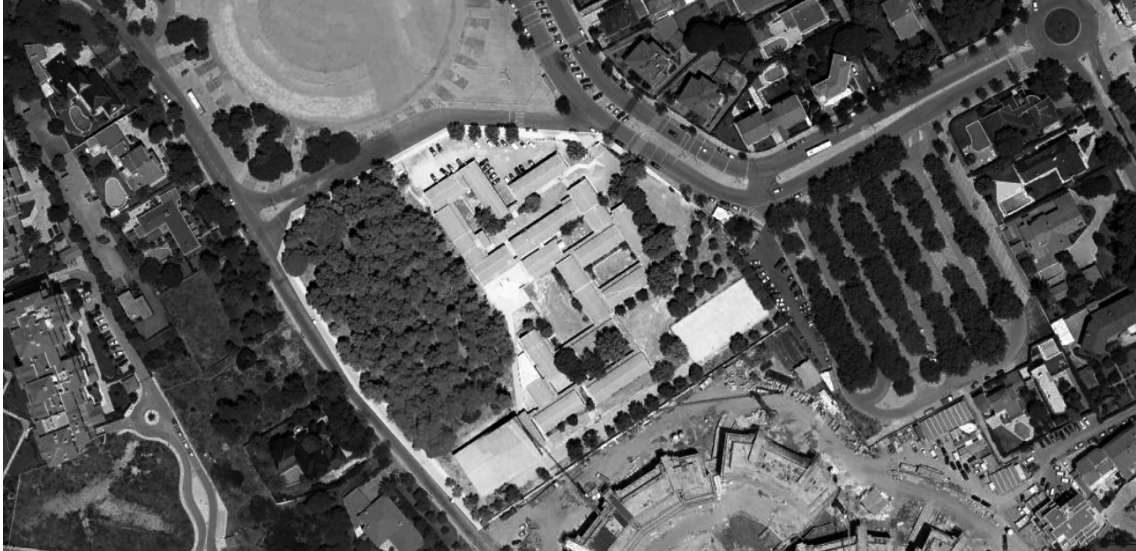
Imagem 45- Área de Intervenção
