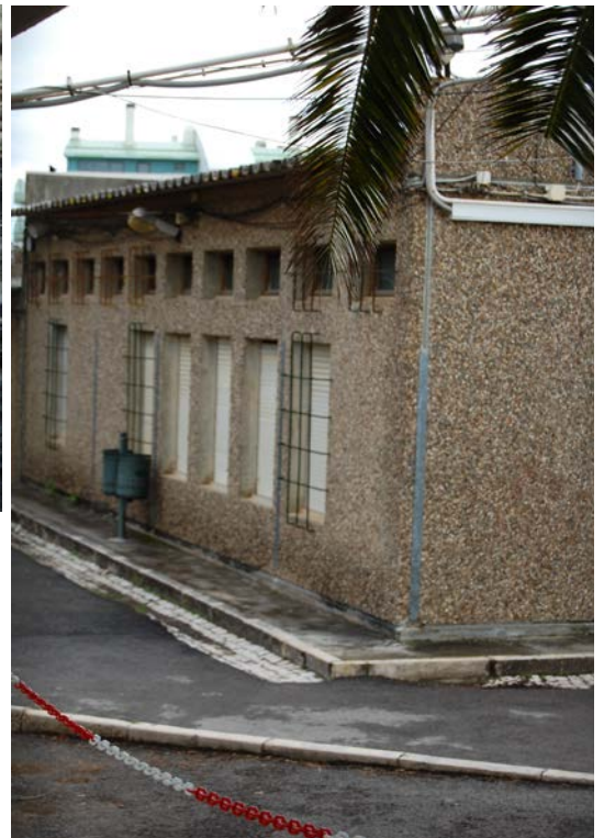
Fotografia 13: Pavilhão da administração – na zona de entrada
