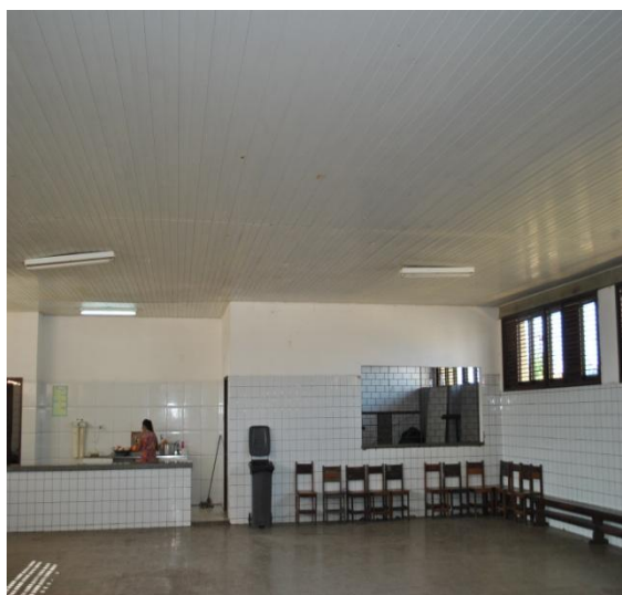
Fotografia 7 – Refeitório da escola
