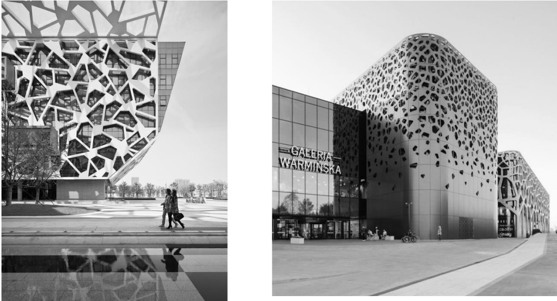
Figura 10 - Fachadas da empresa Alibaba, em Hangzhou, (esquerda) e da Galeria Warminska, em Olsztyn (direita). Créditos: Peter Bennetts e Kuryłowicz & Associates
