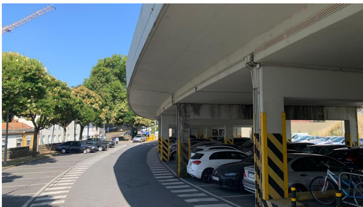
Figura 19. Fotografia do Viaduto Duque de Loulé, vista sul (Fonte: Autor)
