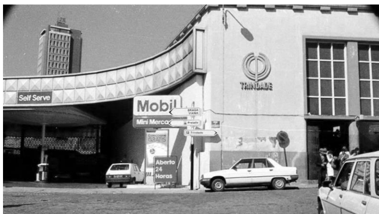
Figura 35. Imagem da antiga Bomba de Gasolina (Fonte: https://www.facebook.com/fotosdoporto/posts/7016155158455476/?locale=ms_MY )
