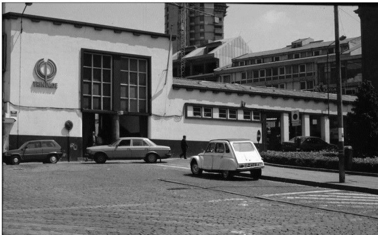
Figura 34. Imagem da Fachada da antiga Estação Ferroviária da Trindade (Fonte: Delcampe.net)
