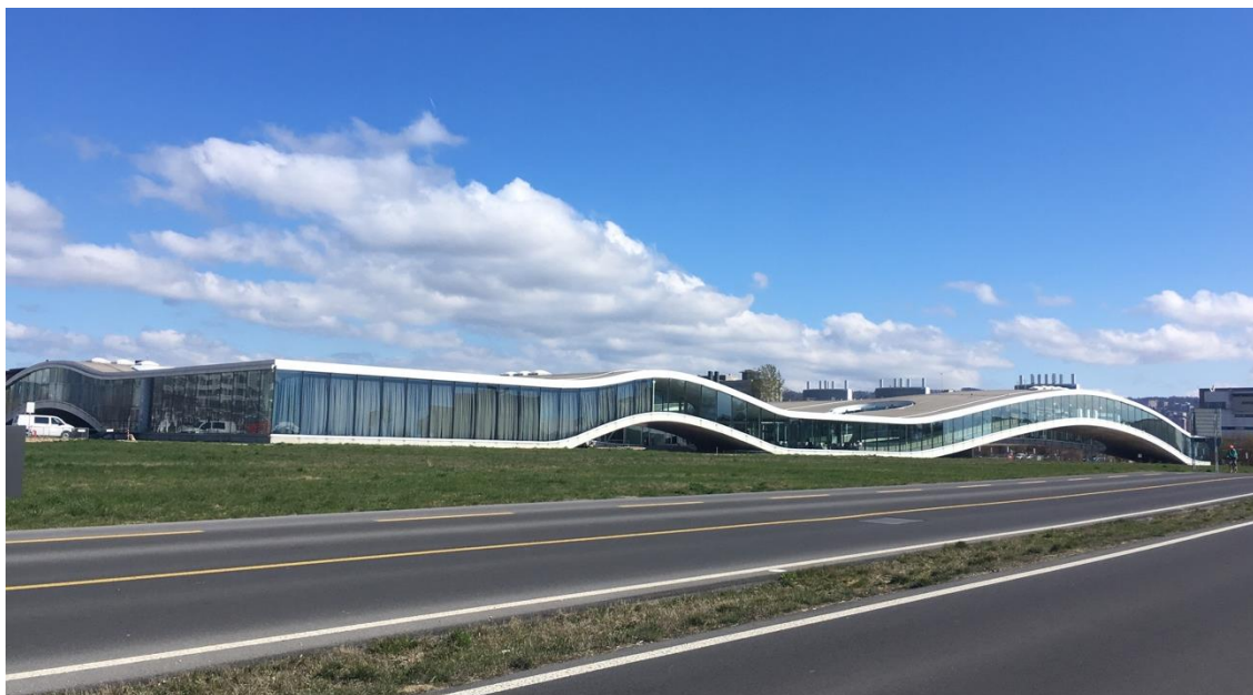
Figura 27 - Rolex Learning Center, Kazuyo Sejima & Ryue Nishizawa, SANAA, Lausanne, Suíça, 2019 - Fotografia tirada pelo autor
