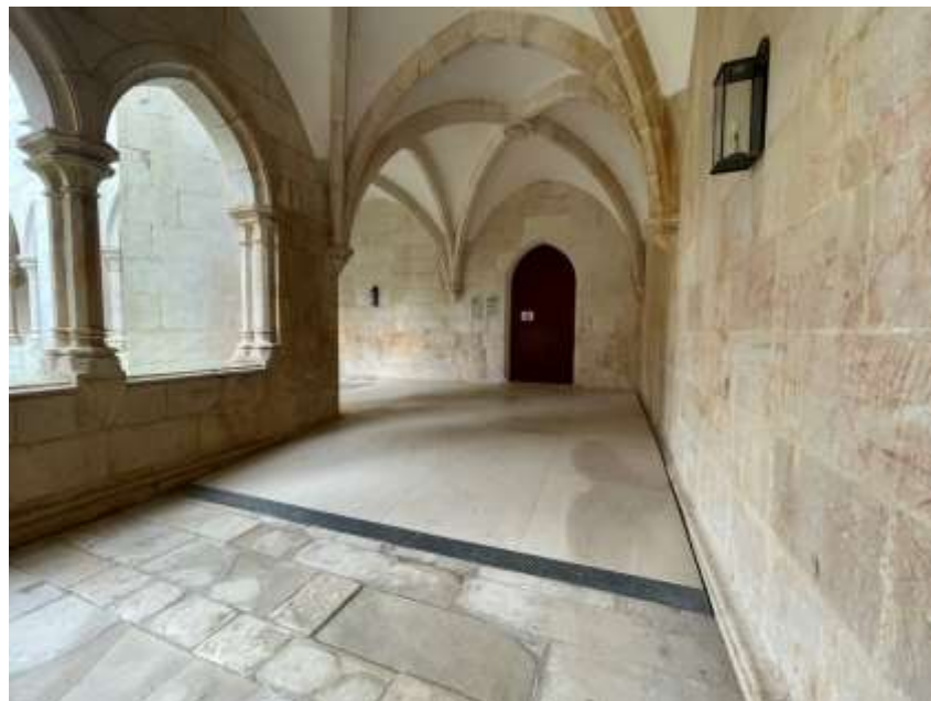
Figura 8: Rampas de acesso no Claustro D. Afonso V
