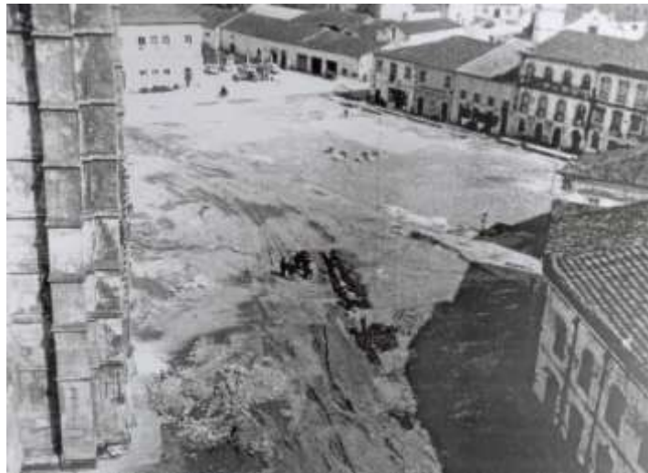
Figura 30: Obras de modificação na Vila da Batalha em torno do Mosteiro. Fonte: Sítio web da Câmara Municipal da Batalha
