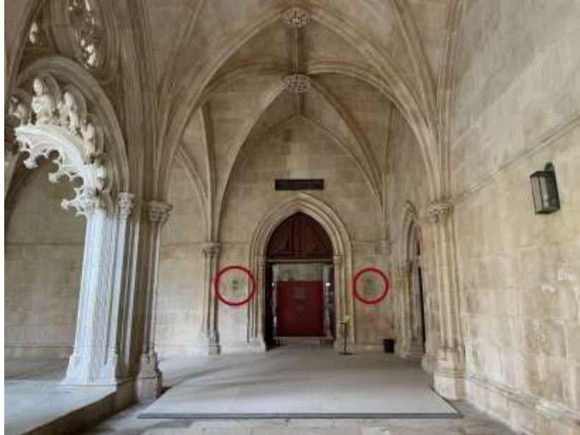
Figura 7: Placas de sinalização invisibilizadas
