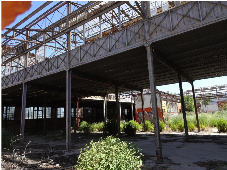
Figura 26: Interior da antiga fábrica A Tabaqueira.
