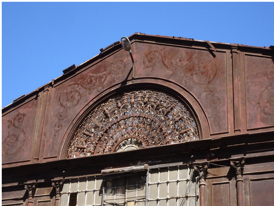
Figura 15: Pormenor da fachada do pavilhão da antiga fábrica A Tabaqueira.
