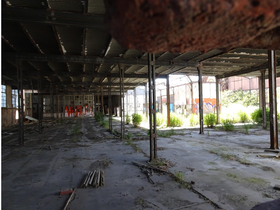
Figura 24: Interior da antiga fábrica A Tabaqueira.
