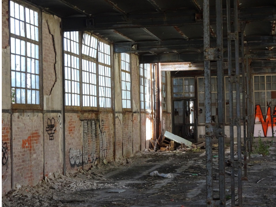
Figura 22: Interior da antiga fábrica A Tabaqueira.
