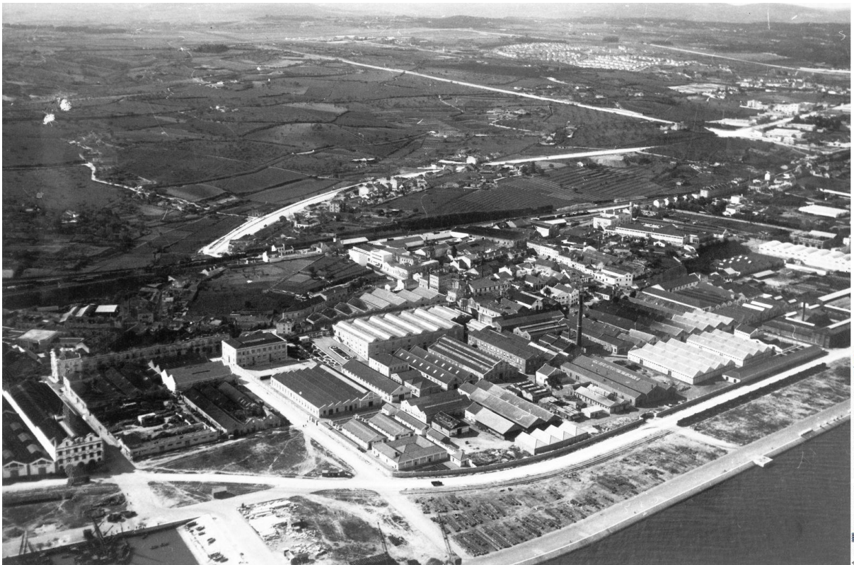
Figura 3: Fotografia aérea sobre a Fábrica Militar de Braço de Prata, 1950. © Arquivo Municipal de Lisboa, SPT000196.
