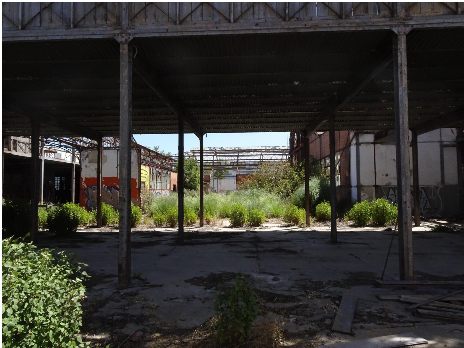
Figura 25: Interior da antiga fábrica A Tabaqueira.
