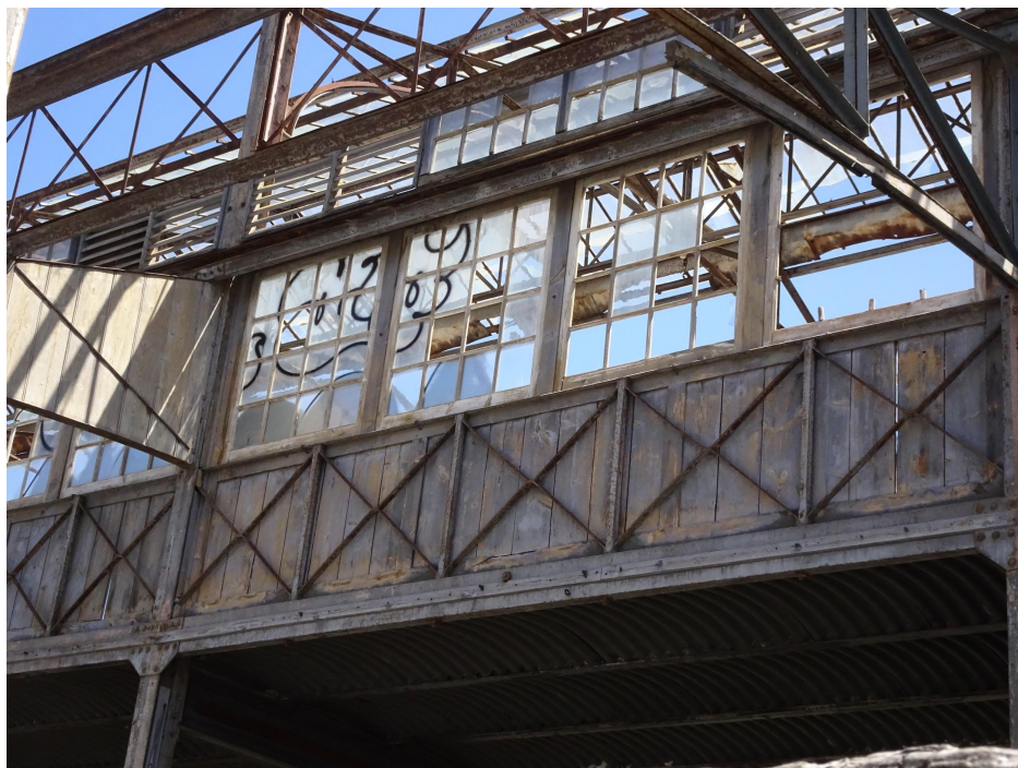
Figura 28: Interior da antiga fábrica A Tabaqueira.
