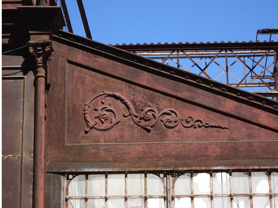
Figura 14: Pormenor da fachada do pavilhão da antiga fábrica A Tabaqueira.
