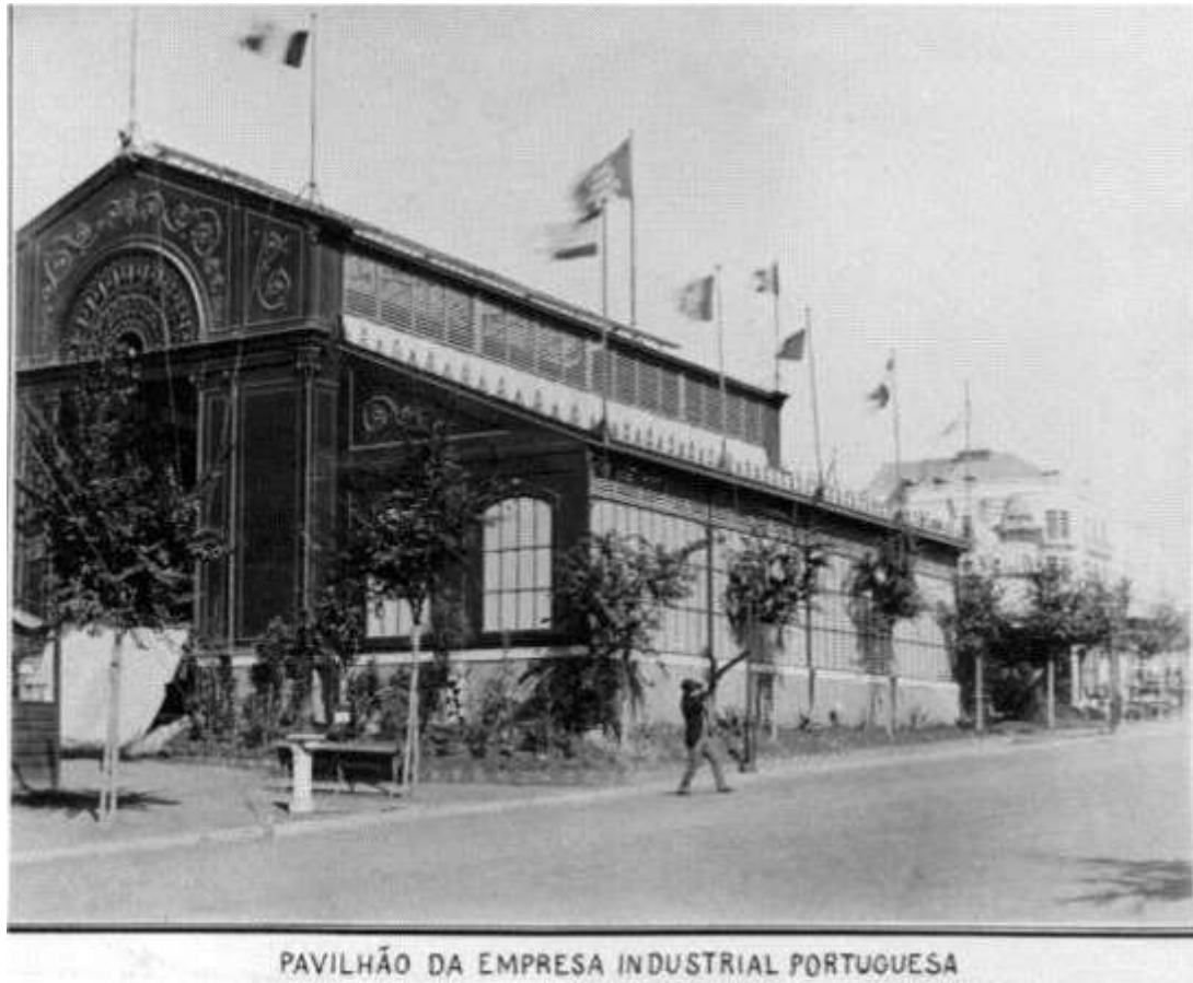
Figura 7: Pavilhão da Empresa Industrial Portuguesa na Exposição Industrial Portuguesa de 1888.
