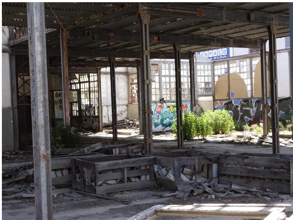
Figura 27: Interior da antiga fábrica A Tabaqueira.
