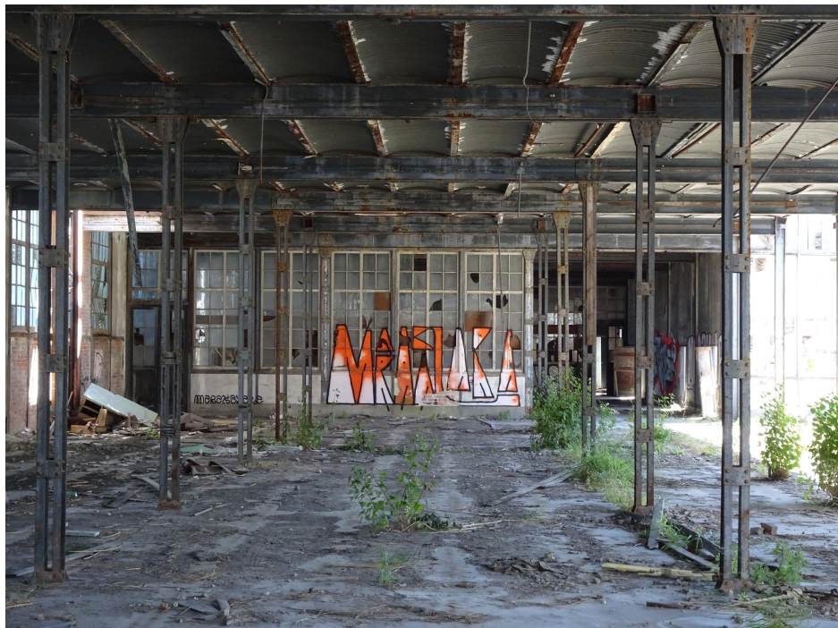
Figura 23: Interior da antiga fábrica A Tabaqueira.
