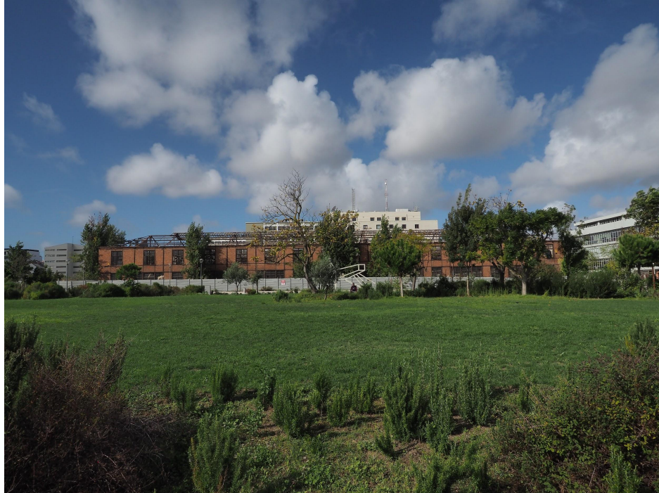
Figura 18: Vista geral da antiga fábrica A Tabaqueira.
