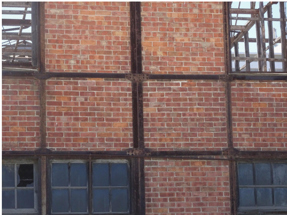
Figura 19: Pormenor da fachada do pavilhão da antiga fábrica A Tabaqueira.
