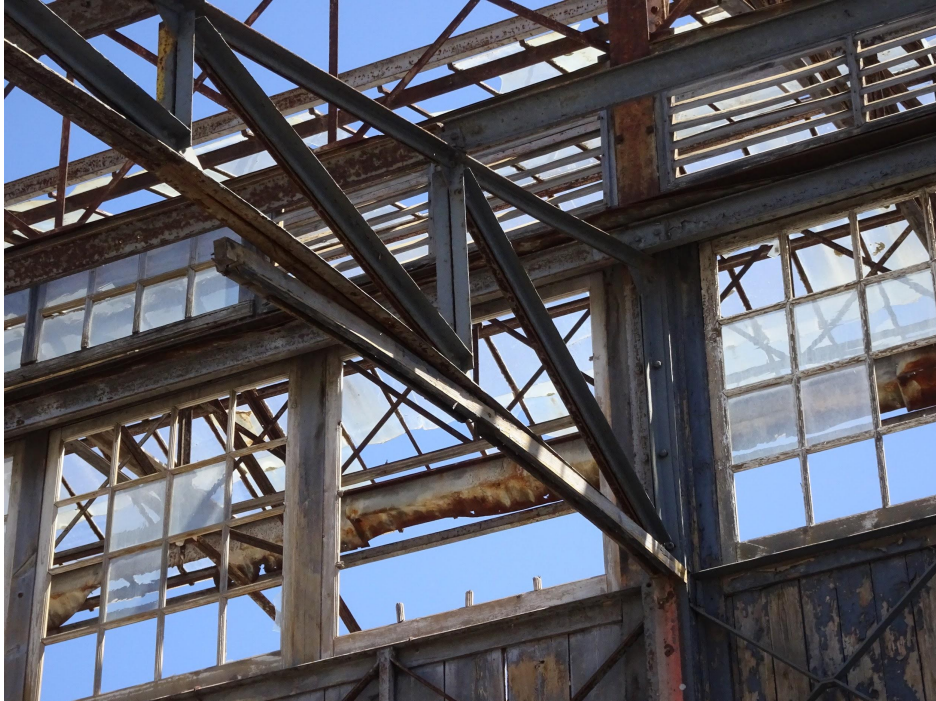
Figura 30: Interior da antiga fábrica A Tabaqueira.
