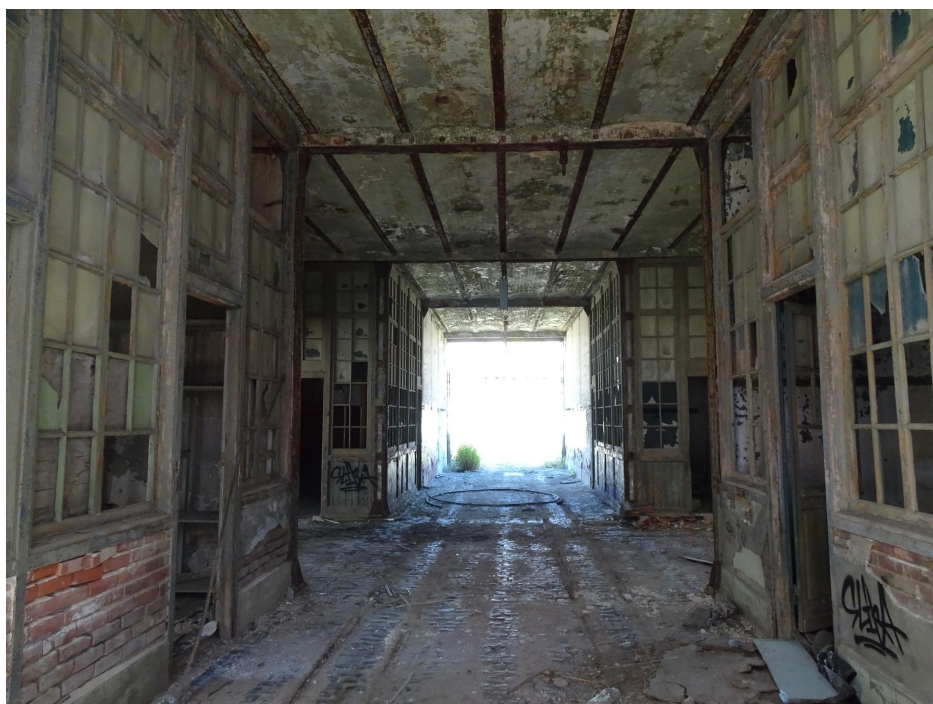
Figura 29: Interior da antiga fábrica A Tabaqueira.
