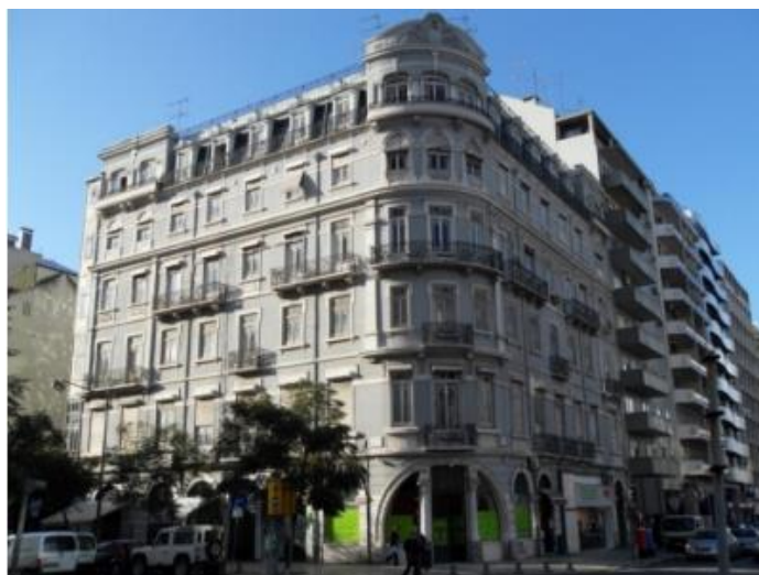
Figura 2-4 – Edifício “Gaioleiro”, localizado na Av. Da República, em Lisboa.
