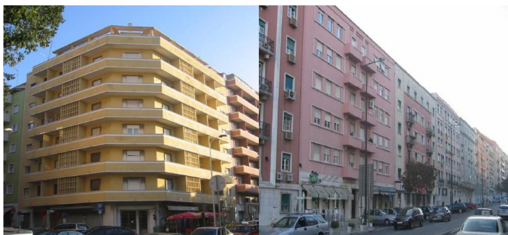
Figura 2-6 – Edifícios de betão com grande percentagem de alvenaria.
