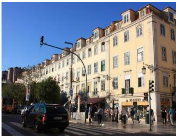
Figura 2-3 – Edifícios do tipo “Pombalino”, localizados na Praça do Rossio em Lisboa.
