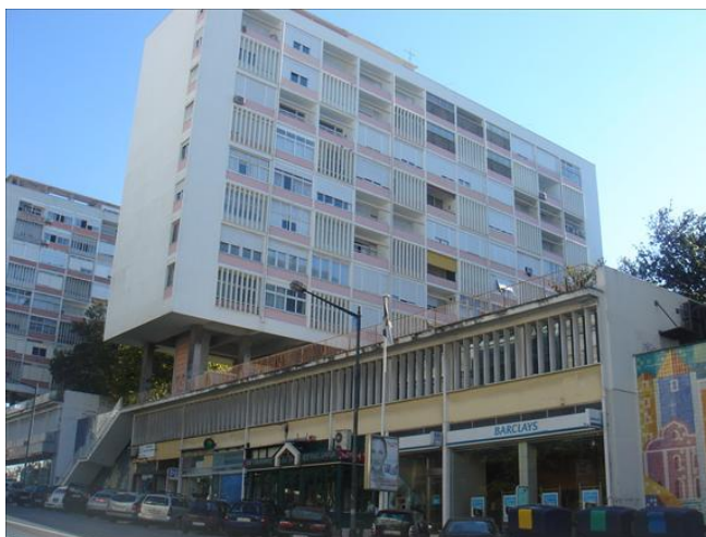
Figura 2-7 – Edifício de betão armado dimensionado de acordo com as primeiras regulamentações sismo-resistentes, situado na Av. Infante Santo em Lisboa.
