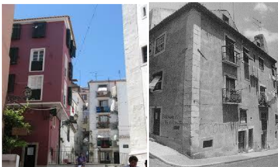
Figura 2-2 – Exemplo de edifícios Pré-Pombalinos; à esquerda Prédio de resalto localizado em Alfama, Lisboa; à direita, Prédio de 4 pisos, águas furçadas e uma loja localizado na rua das Salgueiras em Lisboa.
