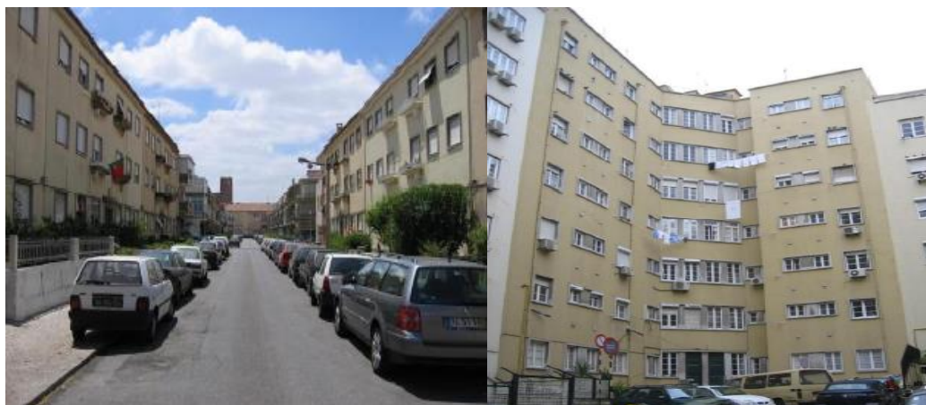
Figura 2-5 – Edifícios mistos de alvenaria e betão, situado no Bairro de Alvalade em Lisboa.
