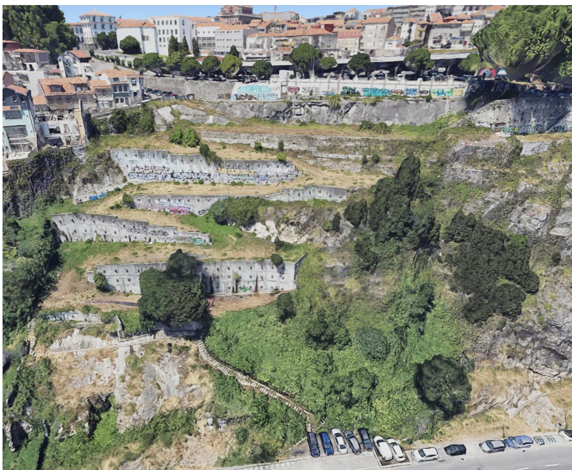
Figura 32 - Vista sobre a porção da escarpa a intervir
