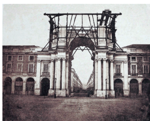
Figura 15 Arco Triunfal da Rua Augusta em construção Data: 1862 Fotógrafo: Václav (Wenceslau) Cifka in AML
