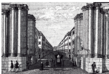
Figura 14 Rua Augusta vendo-se as colunatas compósitas do arco triunfal colocadas em 1815. Nesta estampa, o enfiamento pombalino puro da artéria central da Baixa antes de ser construído o remate do Arco Triunfal. Data: meados do séc. XIX Autor não identificado in Coleção J. Bércia
