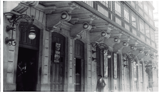
Figura 42 Rua dos Condes - Rua das Portas de Santo Antão Cinema Odeon Data: ant. 1931 Fotógrafo: Estúdio Horácio Novais in Biblioteca de Arte da F.C.G
