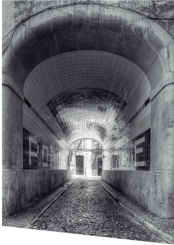
Figura 50 Rua das Portas de Santo Antão Túnel de acesso ao Pátio do Tronco Data: post. 1992 Fotógrafo não identificado
