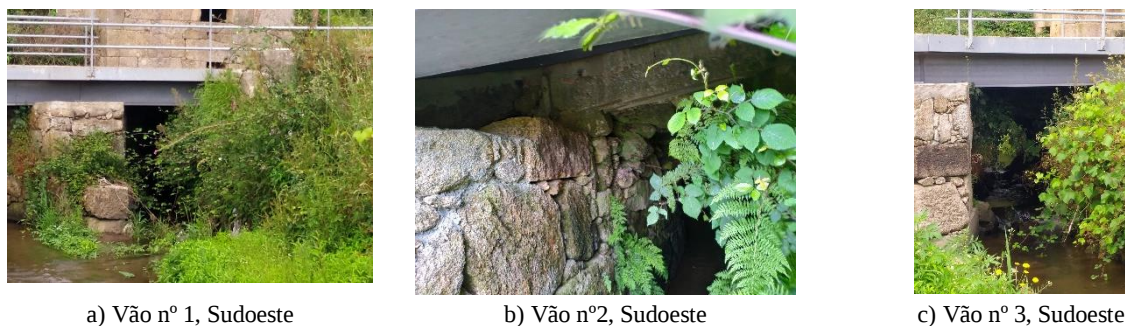
Figura 3.23 - Vãos em viga contínua da Ponte do Verdeal
