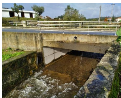
b) Pontão em pórtico de betão armado (Ponte de Enxate, na UF de Vila Cova e Feitos)
