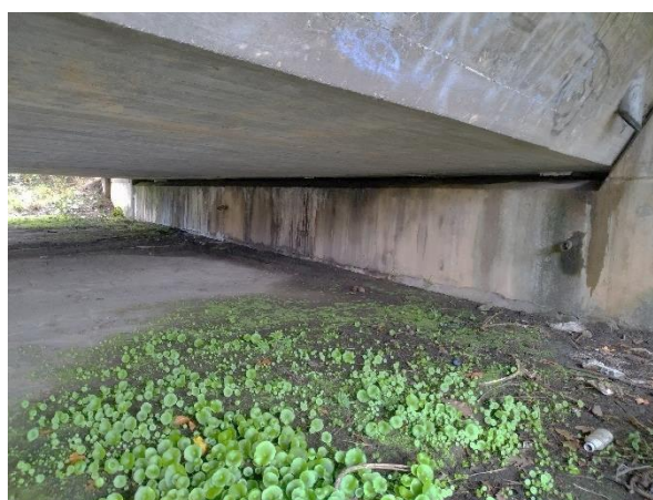
b) Passagem Superior da Circular de Barcelos (freguesia de Arcozelo)
