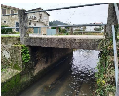
a) Pontão de betão armado com sistema em viga simplesmente apoiada (freguesia de Alvelos)
