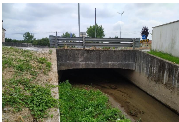
Figura 4.37 - Muro de testa de ambos os lados (pontão de betão armado na UF de Viatodos, Grimancelos, Minhotães e Monte de Fralães)
