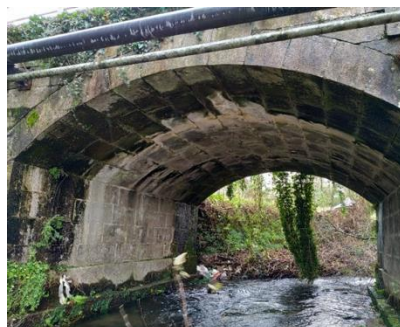
b) Ponte em arco de alvenaria de pedra (Ponte do Fulão, na freguesia de Fragoso)
