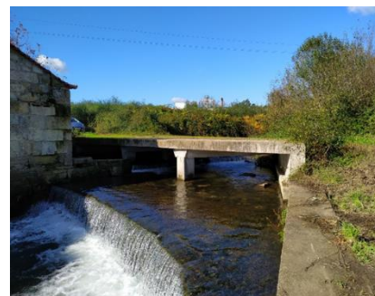
c) Ponte de betão armado com viga contínua (freguesia de Galegos - Santa Maria)
