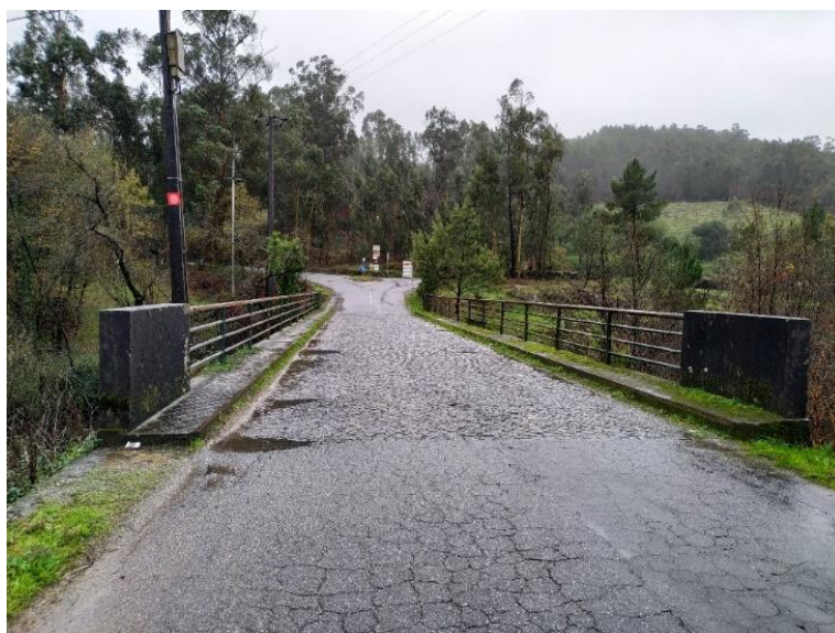
Figura 3.13 - Vista superior da Ponte Nova, Norte
