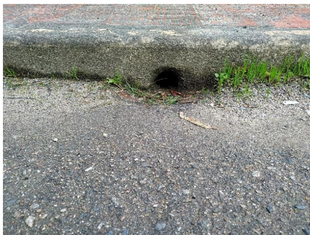
Figura 4.43 - Bueiro (ponte entre Areias e Pousa, UF de Areias de Vilar e Encourados)
