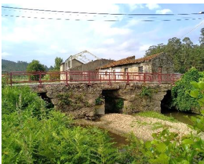
a) Ponte de alvenaria de pedra com viga simplesm. apoiada (Ponte do Rio Este, freg. de Cambeses)
