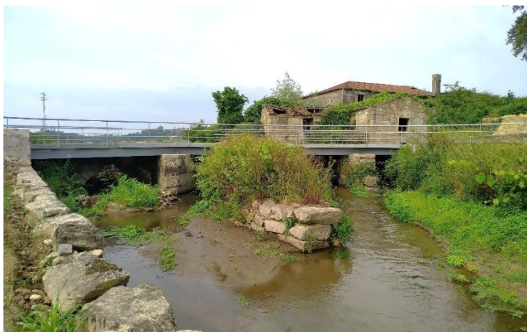
Figura 3.20 - Alçado da Ponte do Verdeal, Sudoeste
