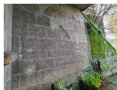
c) Muro de ala, Nordeste
