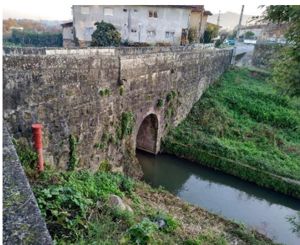
Figura 4.44 - Talude em rampa lateral à via em terra vegetal (Ponte da Igreja, freguesia de Pousa)
