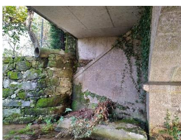
b) Muro de ala, Sudoeste
