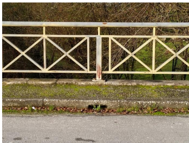
Figura 3.18 - Guarda-corpos, passeio e bueiro da Ponte da Breia
