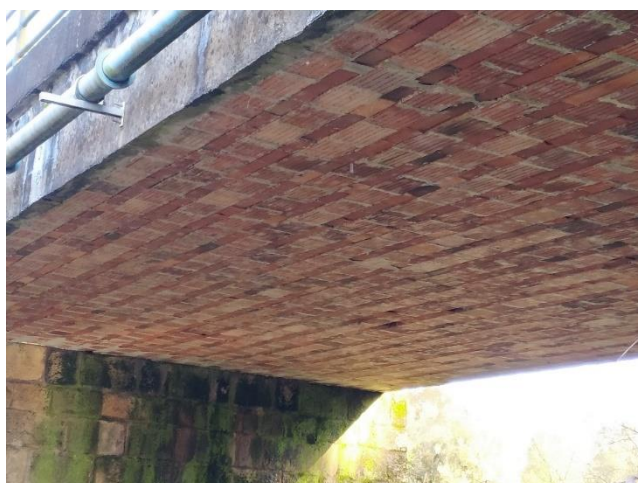
Figura 3.12 - Vista inferior do tabuleiro da Ponte Nova
