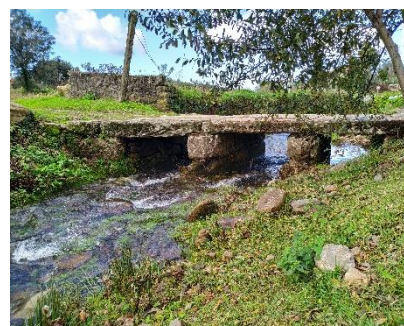
c) Pontão de alvenaria de pedra com viga simplesmente apoiada (freguesia de Fragoso)
