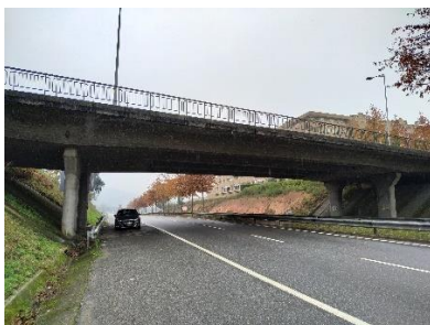
d) Passagem superior da Circular de Barcelos (freguesia de Arcozelo)
