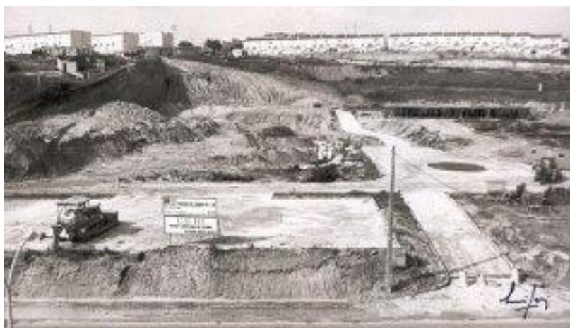
Fig.3 Início das obras do Colégio
