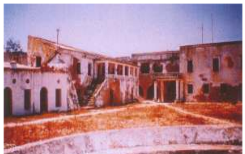
30. O interior da Fortaleza de São Sebastião mostra as construções portuguesas presentes em todos os edifícios desta natureza. The St. Sebastian Fortress interior shows that all the buildings of this nature displayed a Portuguese influence.
