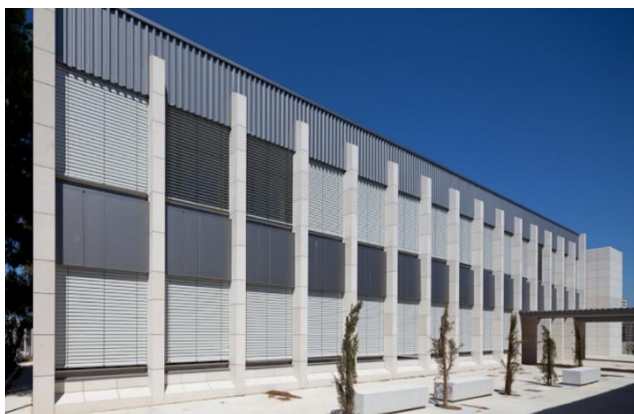
Figura 6 ESAD vista exterior
