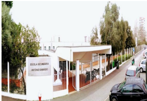
Figura 5 ESAD entrada lateral
