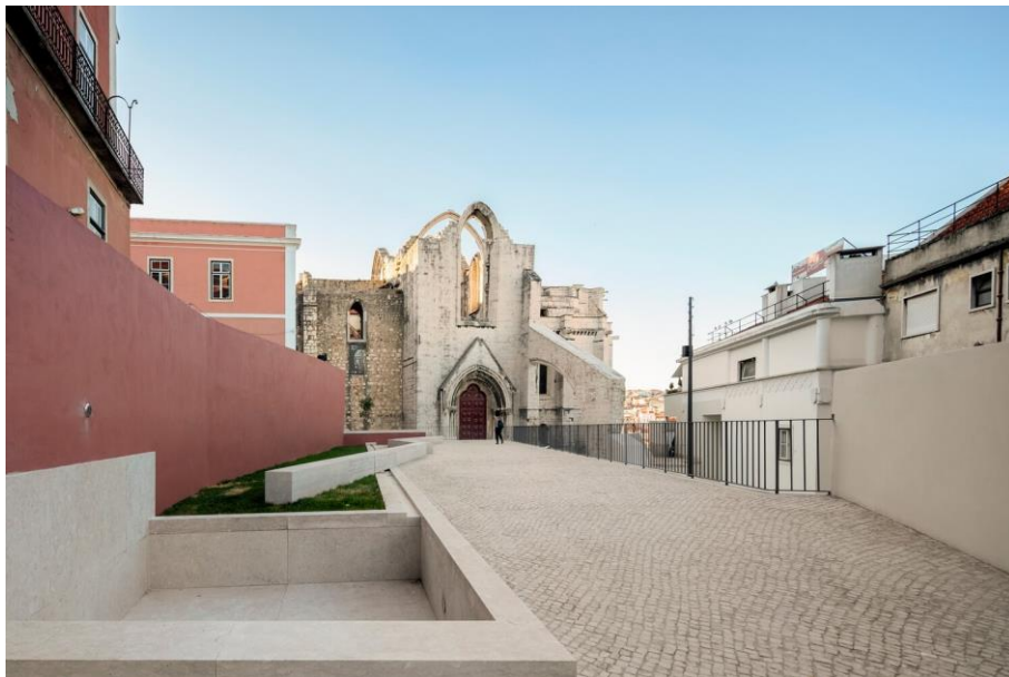
Fig.18- Fotografia do caminho junto ao portal Sul da Igreja do Carmo
