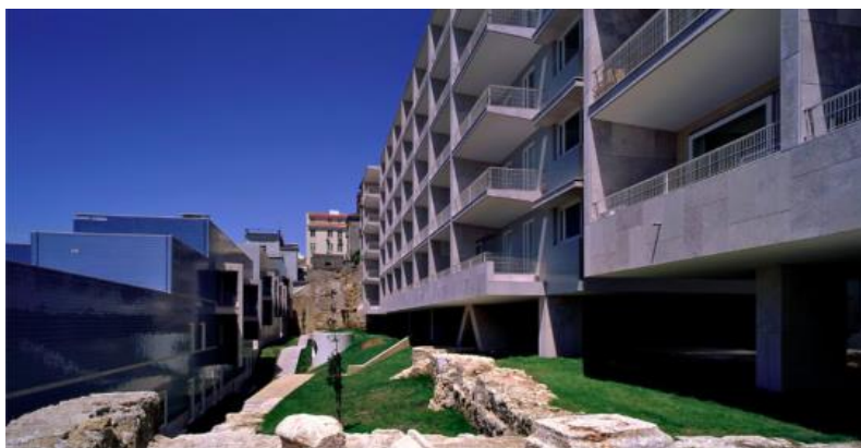
Fig.25- Fotografia do interior do terreno dos Terraços de Bragança
