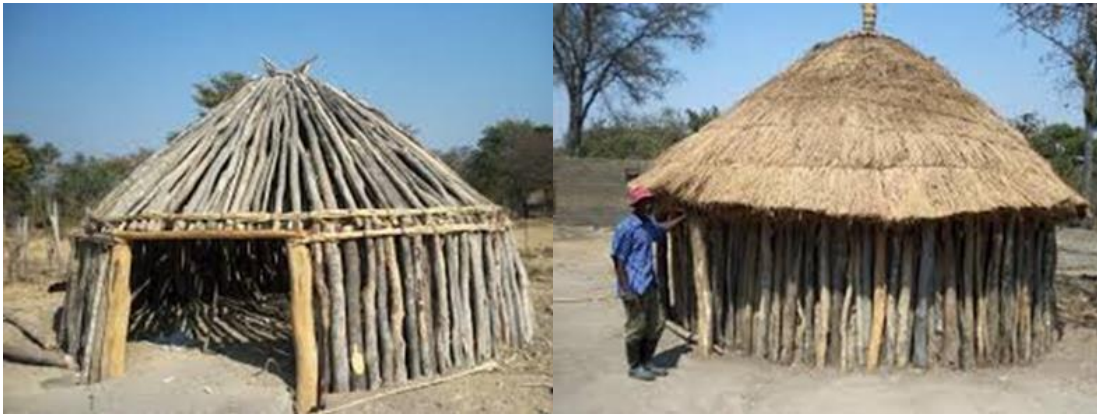
Figura 7- Fase da construção e fase final da construção de uma casa de pau-a-pique em Qué-Chikomba – Huíla; Pág 142 e 143; Autor: Domingos Dias
