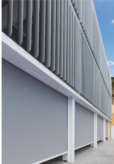
**Figura 30** - Laminas metálicas Quebra-sol
