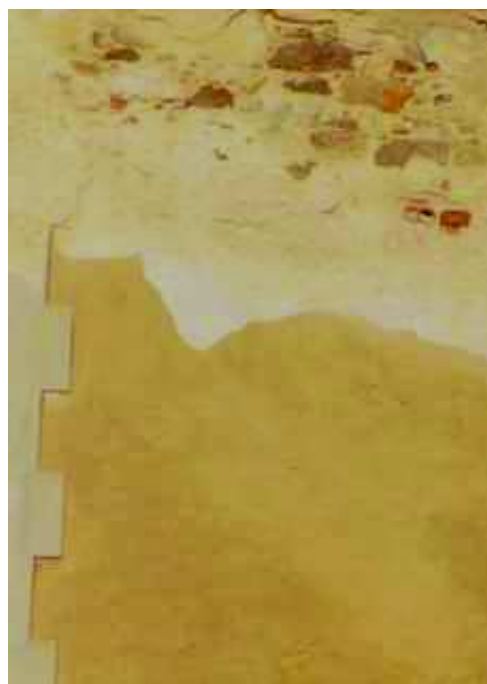
Fig. 32 - Paredes exteriores Reboco
