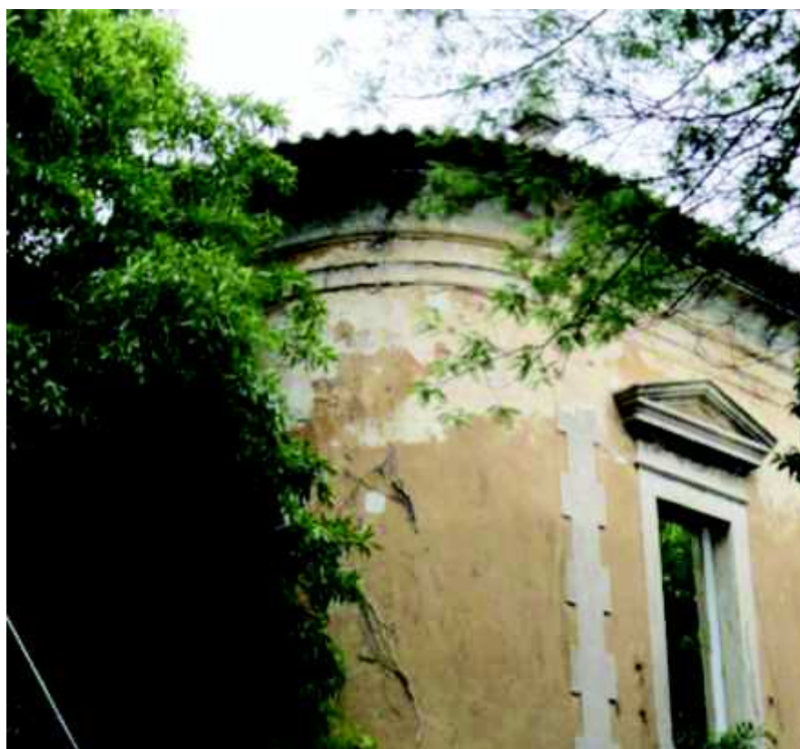
Fig. 39- Remate de Telhados cantos posteriores em redondo
