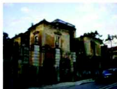
Fig. 71 - Identificação do Palacete - Casa Teixeira Beltrão como Património Arquitectónico - nível 2
