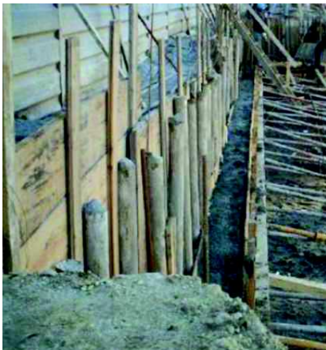
Fig. 41 - Cortina de contenção com recurso a microestacas
