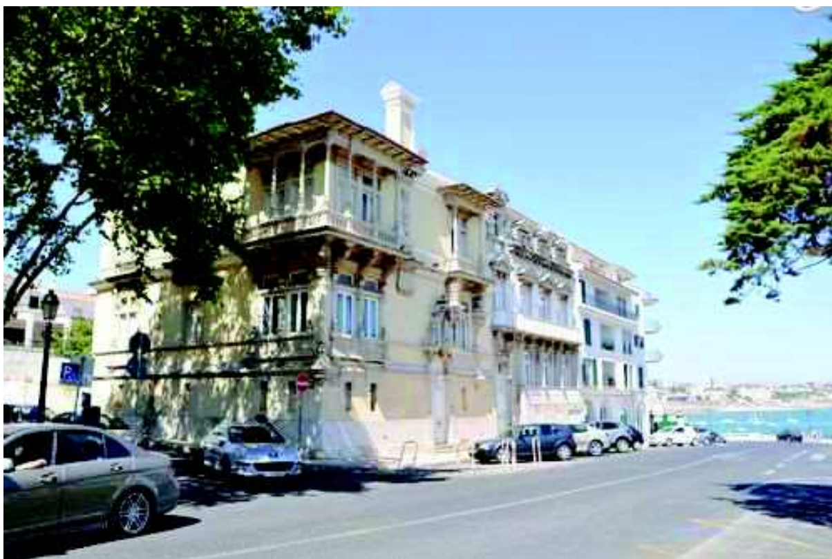
Fig. 5 - Palacetes na Av. D Carlos I in Google Earth acedido em 25-01-2013
