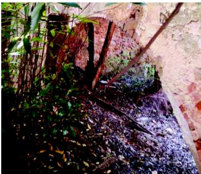
Fig. 35 - Foto das Fundações em alvenaria de pedra, reforçadas em arco
