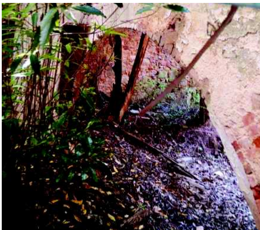
Fig. 27 – Casa Teixeira Beltrão - Foto Fundações reforçadas em arco
