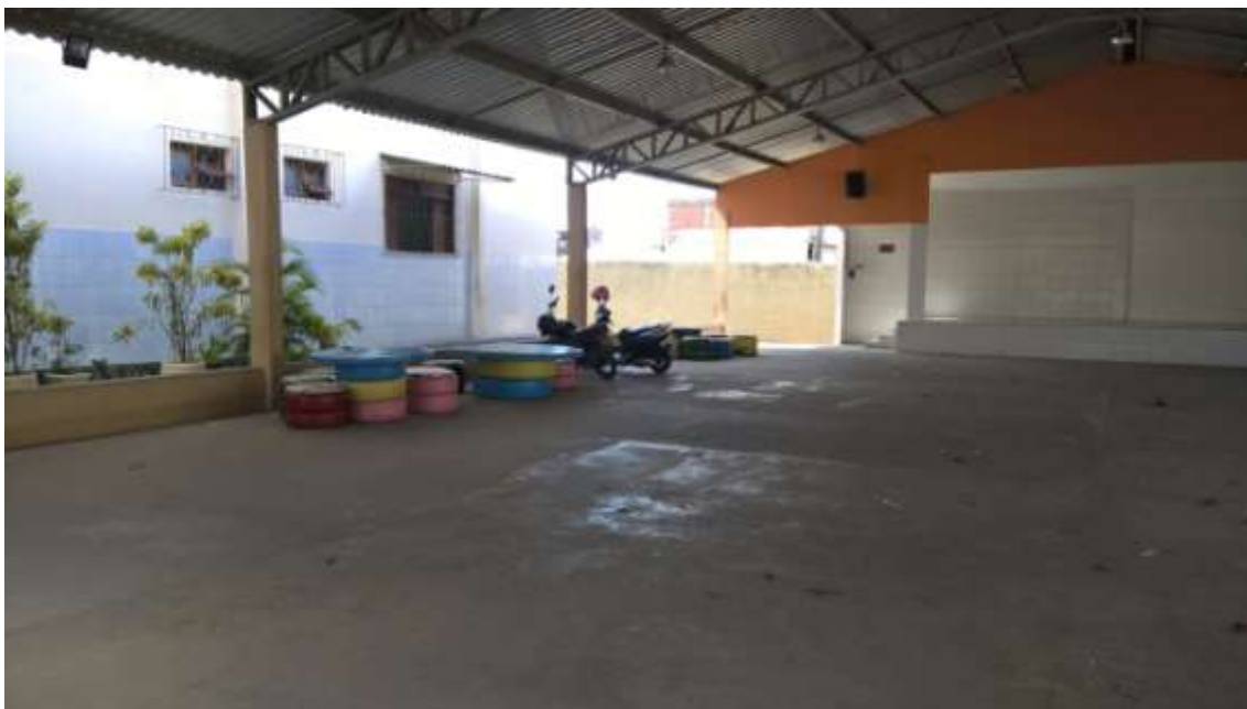
Figura 2 - Espaço com cobertura e chão de cimento.
