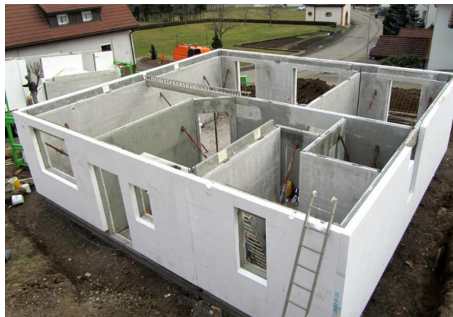
Figura 8: Exemplo de construção pré fabricada utilizando betão. Fonte: site housefy.com.br
