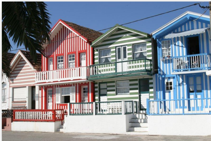
Figura 14: Exemplo de Palheiro reabilitado na Costa Nova. Fonte: site - google.com
