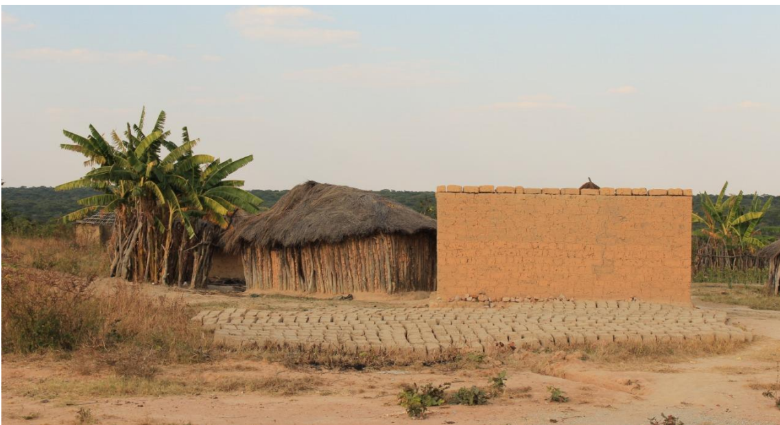
Figura 14. Habitação feita de pau-a-pique ao lado de uma habitação feita de adobe (Imagem recolhida em trabalho de campo).
