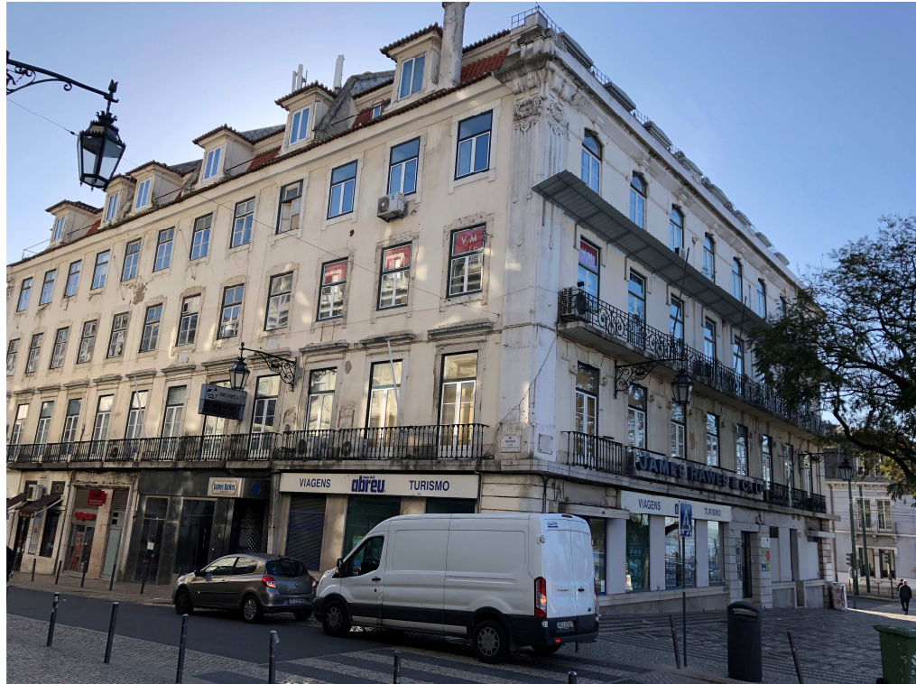
Figura 74 – Edifício - imagens do autor
