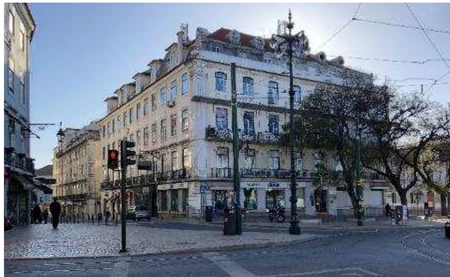
Figura 59 - Fotografia do edifício – imagem do autor
