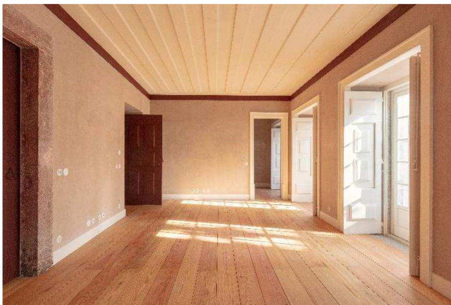
Figura 51 – aspeto do primeiro andar após a obra; Lopes, F (2020); Lisboa arquitetura contemporânea e cidade antiga (pp127)
