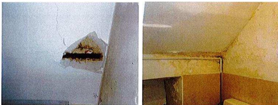
Figura 85 – Desagregações – imagens do autor
