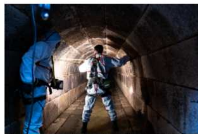
Coletor U invertido em saiméis - Largo do Intendente Pina Marique; Fotografia Manuel Leiva; Arquivo Departamento de Marca e Comunicação; Câmara Municipal de Lisboa.
