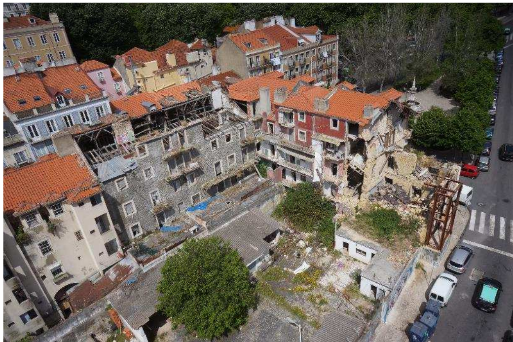
Figura 53 – vista aérea do local, antes da intervenção; Lopes, F (2020); Lisboa arquitetura contemporânea e cidade antiga (pp173)
