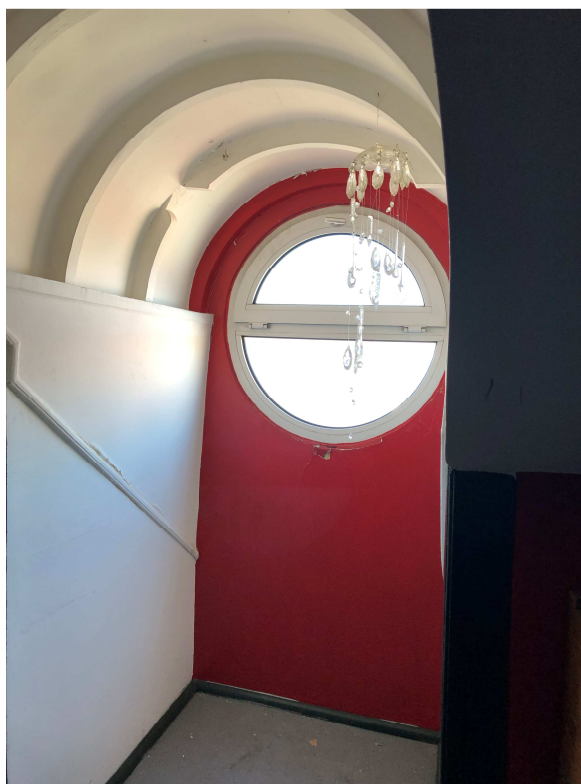
Figura 72 – trapeira - interior – fonte: imagem do autor
