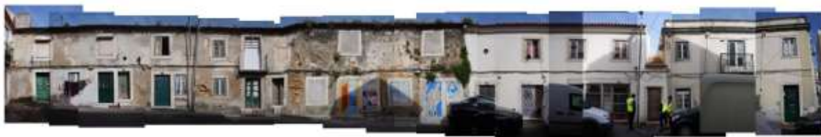
Figura 32- Alçado Norte da Rua da Fonte.
