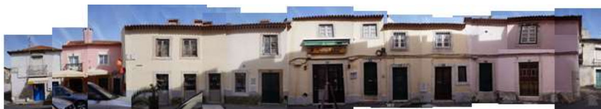
Figura 31- Alçado Norte da Rua da Fonte, mais perto da zona histórica.
