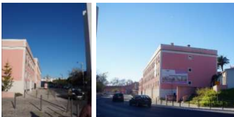
Figura 39 – Edifício n.º 6 da Rua Maria Brown, adjacente ao edifício de gaveto da Rua da Fonte.
