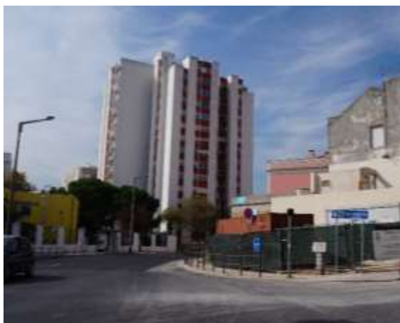
Figura 15 - Edifício da Quinta da Luz.
