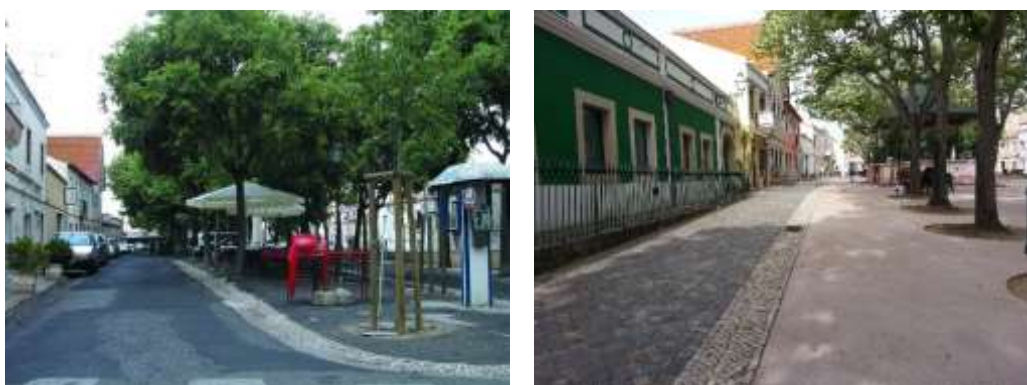
Figura 9 - Antes e depois das obras de reabilitação do largo do Coreto.
