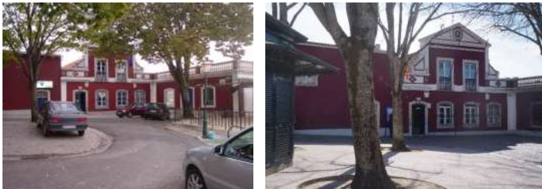
Figura 10 - Pormenor do pavimento do largo do Coreto, antes e depois das obras de reabilitação.
