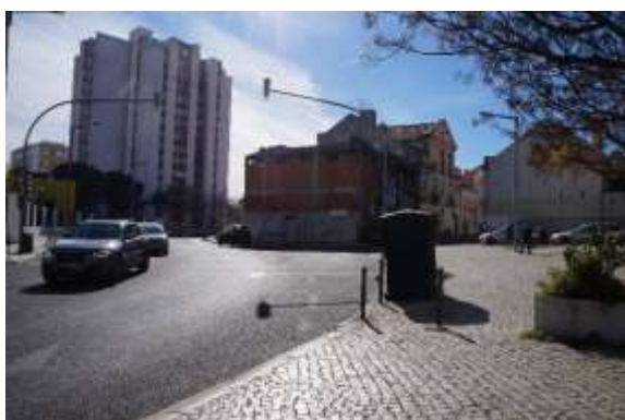
Figura 46-Vista para a bifurcação da Rua da Fonte com a Rua Maria Brown, em Janeiro 2015.
