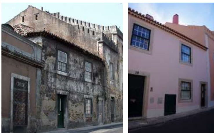
Figura 37 - Edifício de habitação, n.º 47, antes e depois de ser reabilitado.
