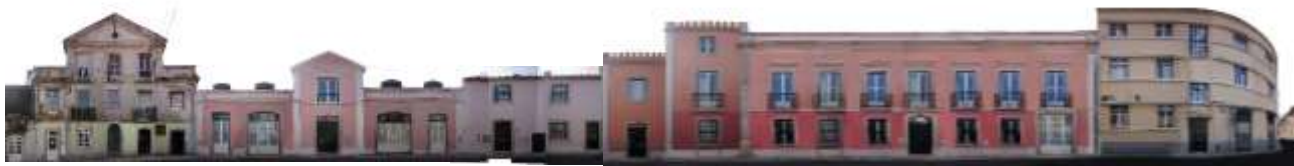
Figura 33- Alçado Sul da Rua da Fonte.
