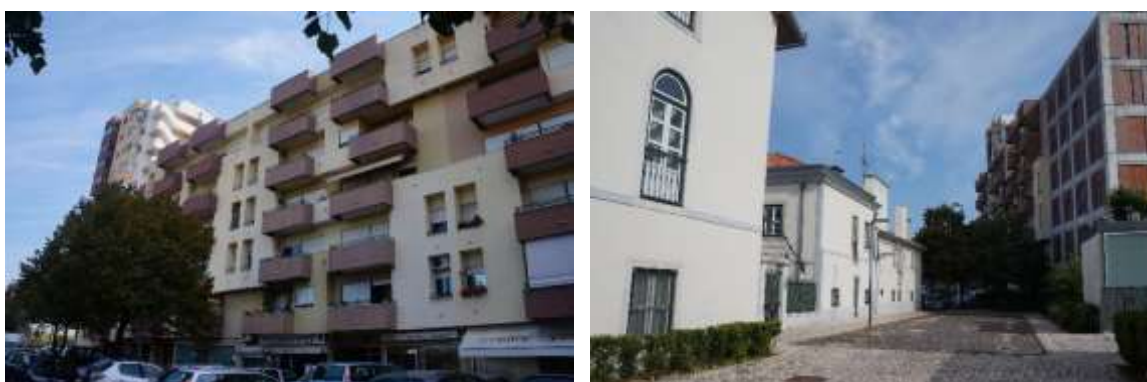
Figura 20 - Edifícios da Azinhaga dos Carmelitas.
