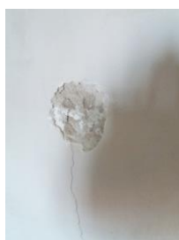
Figura 13. Parede de betão armado fonte: Autor (2017)
