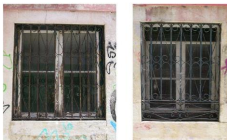
Figura 31 e 32. Gradeamentos metálicos das janelas do piso 0 na Rua dos Caetanós fonte: (Appleton & Domingos, 2017)
