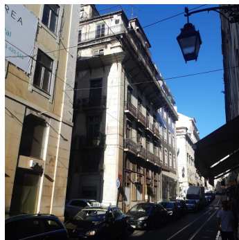
Figura 2. Edifício na Rua dos Douradores fonte: Autor (2019)
