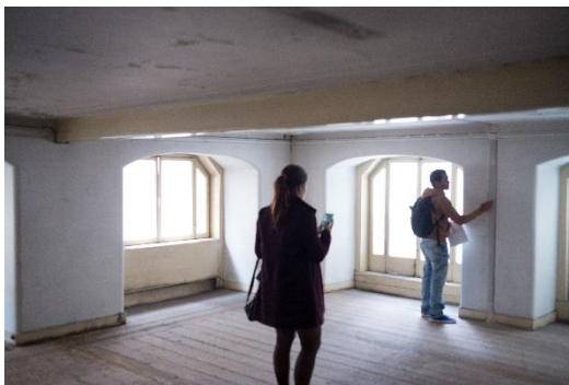
Figura 73. Edifício na Rua dos Douradores, interior fonte: Autor (2017)
