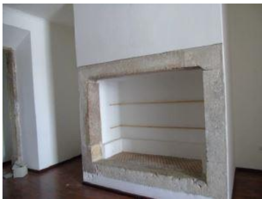
Figura 106. Edifício no Rossio interior fonte: Ana Almeida (2017)
