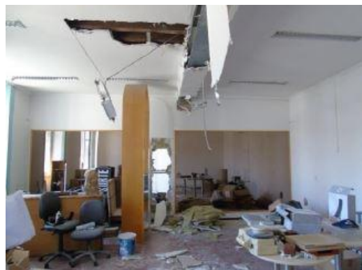
Figura 107. Edifício no Rossio interior fonte: Ana Almeida (2017)
