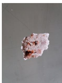
Figura 14. Parede de alvenaria de tijolo fonte: Autor (2017)
