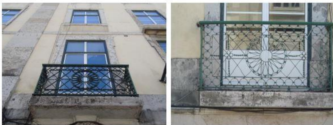
Figura 108 e 109. Fachadas do prédio virada para a Praça D. João da Câmara: pormenor de uma janela desacadada com gradeamento ao nível do 1.º andar fonte: Ana Almeida (2017)
