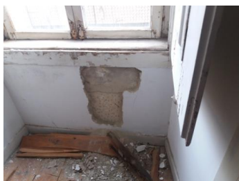
Figura 10. Parede de alvenaria de pedra fonte: Autor (2017)
