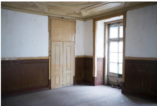
Figura 75. Edifício na Rua dos Douradores, interior fonte: Autor (2017)
