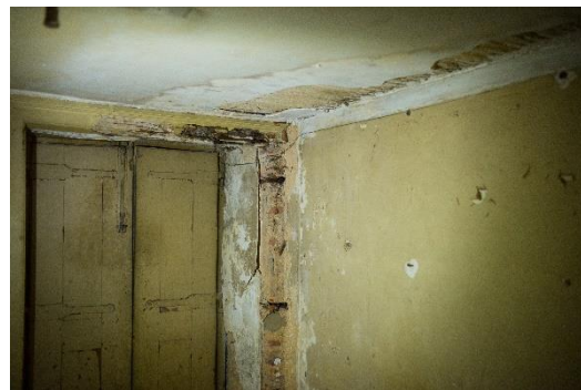
Figura 74. Edifício na Rua dos Douradores, interior fonte: Autor (2017)
