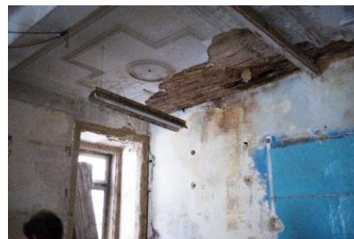
Figura 131. Edifício na Rua dos Douradores, interior fonte: Autor (2017)
