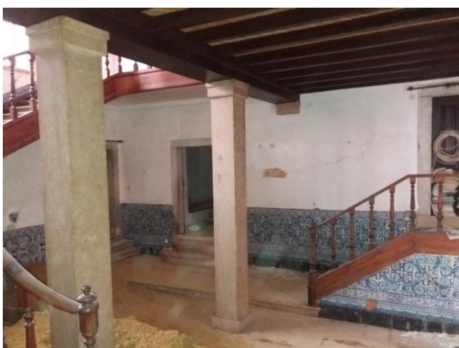
Figura 25. Edifício Palácio Ficalho, sala de entrada do piso térreo. fonte: Autor (2017)
