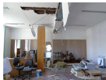
Figura 133. Edifício no Rossio, interior fonte: Ana Almeida (2017)
