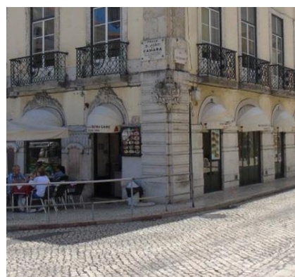
Figura 111. Pormenor das transições das fachadas voltadas à Praça D. João da Câmara e Rua 1.º de Dezembro fonte: Autor (2019)
