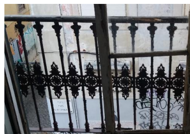
Figura 33. Pormenor gradeamentos metálicos utilizados nas janelas fonte: (Appleton & Domingos, 2017)
