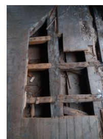
Figura 16. Laje ou pacimento de vigotas fonte: Autor (2017)
