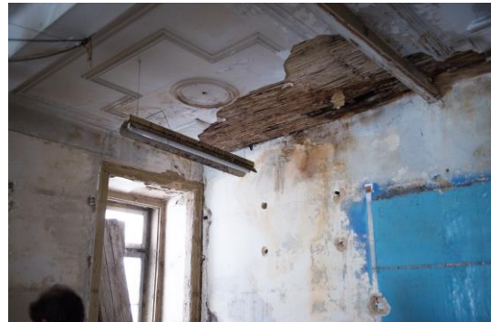
Figura 76. Edifício na Rua dos Douradores, interior fonte: Autor (2017)
