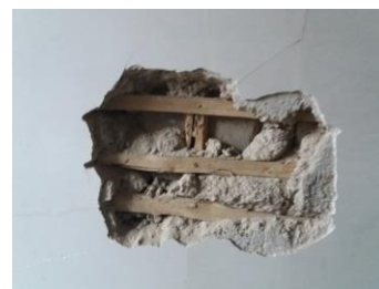
Figura 12. Parede de tabique fonte: Autor (2017)
