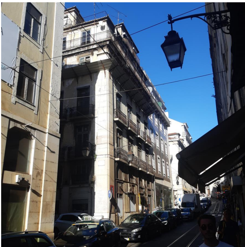
Figura 60. Edifício na Rua dos Douradores fonte: Autor (2019)
