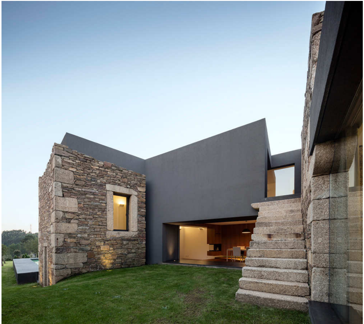
Figura 23 – Vista para a Sala de Jantar
