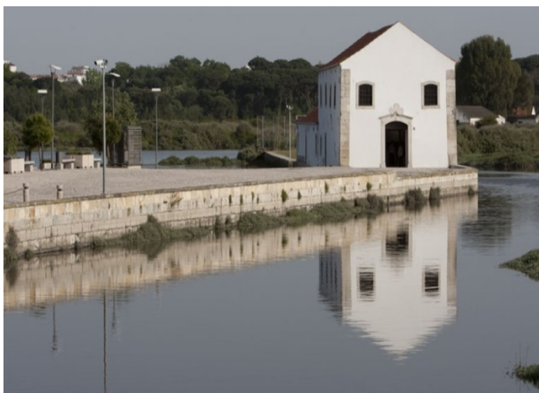
Figura 36 – Moinho de Maré de Corroios. (2016)
