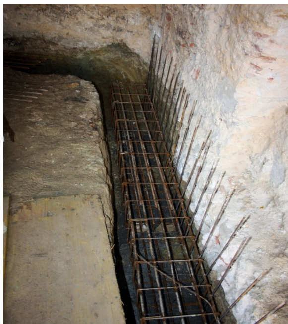
Figura 53 - Fundações de reforço às paredes estruturantes (2017)
