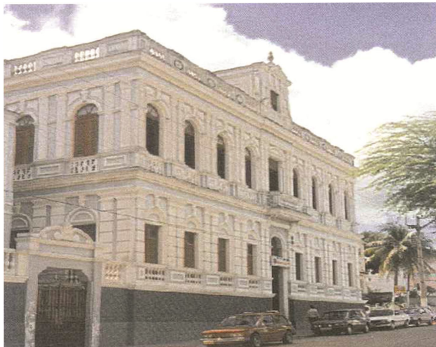
Figura 15 - Residência de Dom José. O prédio construído pelo Senador Francisco de Paula Pessoa para sua residência, entre os anos de 1836 e 1839 (...). Em 1915, foi comprado pela Diocese de Sobral para servir de residência para o Bispo D. José Tupinambá da Frota, que nele morou de 1916 a 1933. Neste ano, transferiu-se para o Sobrado, onde hoje se encontra o Museu Diocesano (Girão & Soares, 1997, p. 47 e 48).
