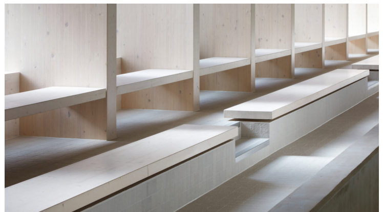
Figura 71 Fotografia bancos, insuflação junto ao caixilho.
