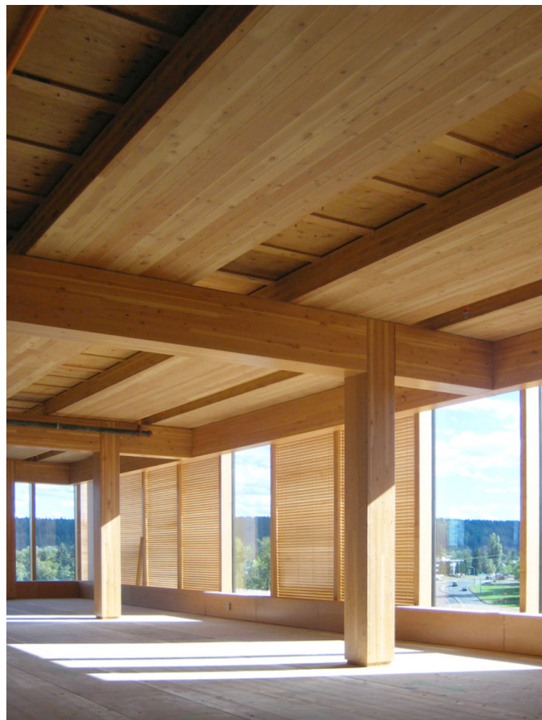
Figura 60 Fotografia do Interior do Edifício.
