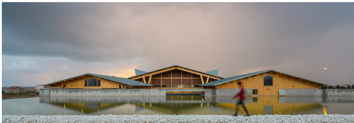
Figura 50 Fotografia do Edifício.
