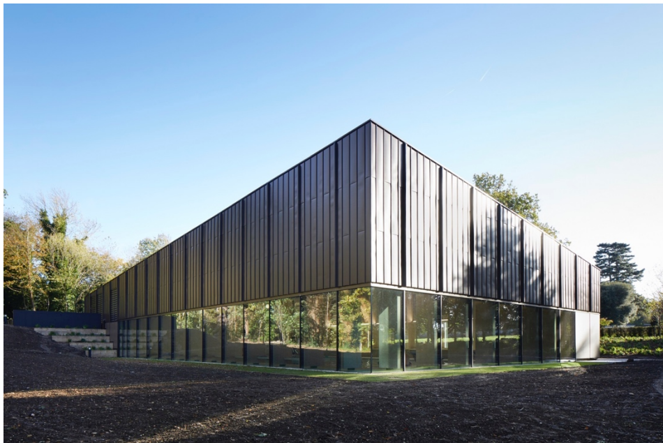
Figura 62 Fotografia do Edifício.
