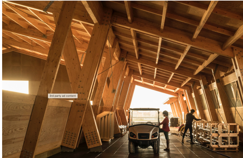
Figura 53 Fotografia do Edifício.
