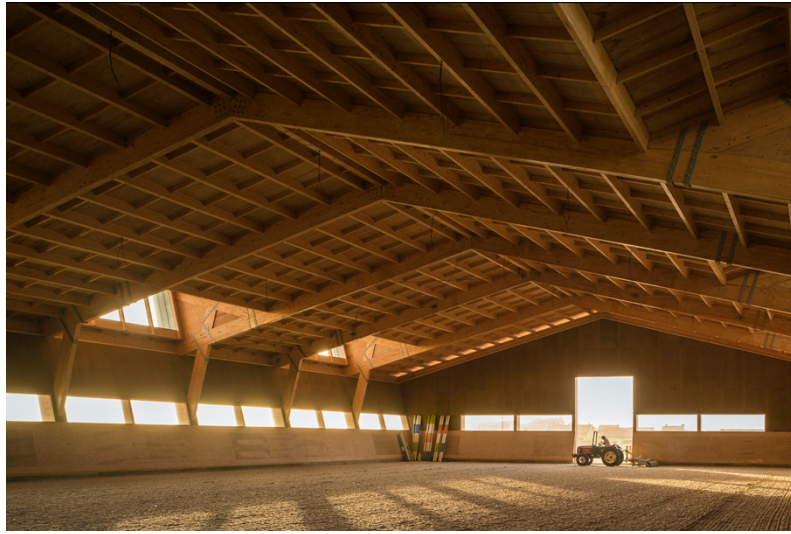
Figura 52 Fotografia do Edifício.
