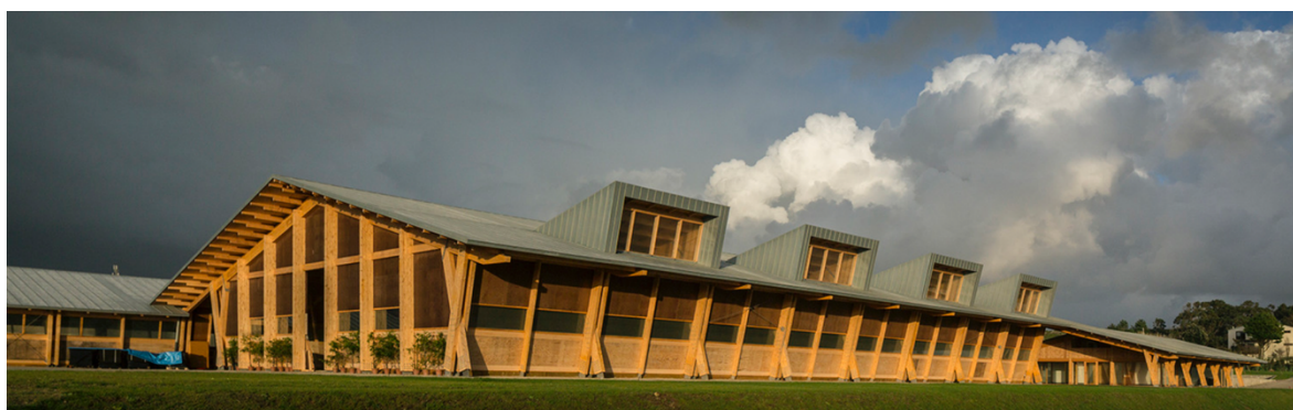
Figura 51 Fotografia do Edifício.
