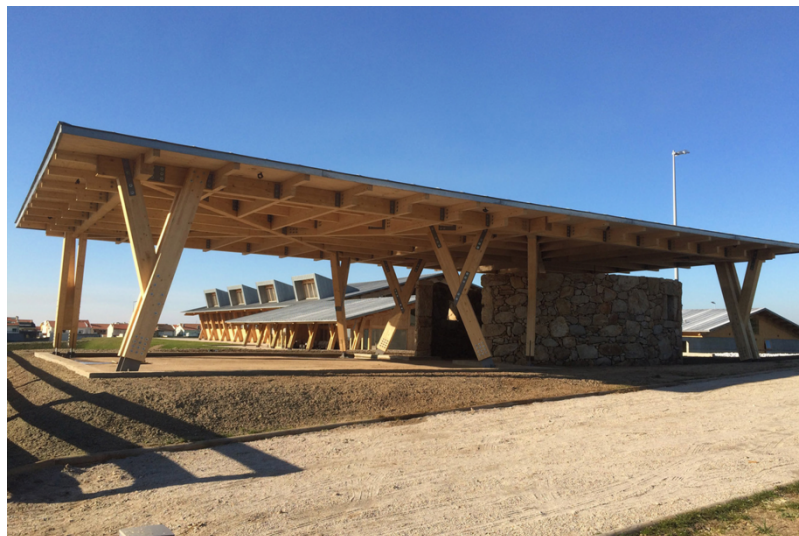
Figura 54 Fotografia do Edifício..
