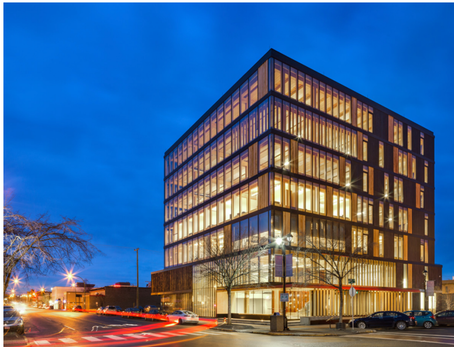
Figura 55 Fotografia do Edifício.
