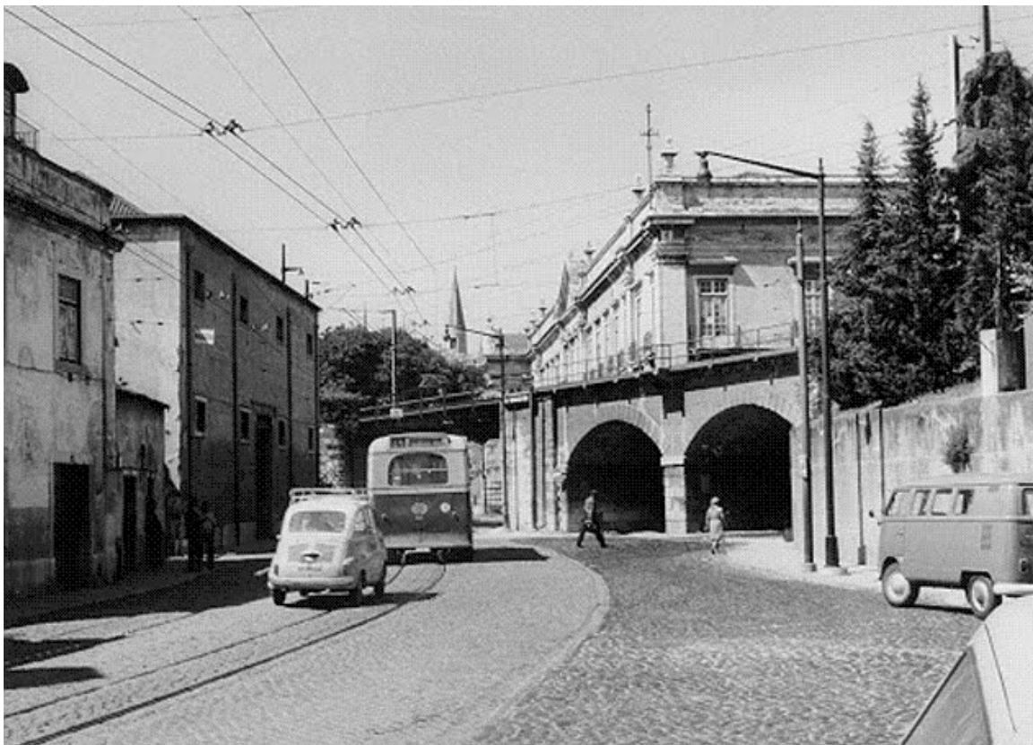
Figura 4 - Viaduto de Xabregas, 1968 (Cf. Bib. de Figuras p.126).
