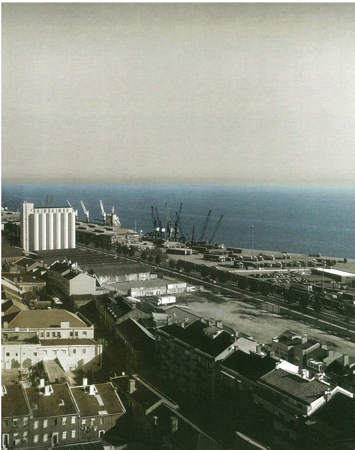
Figura 5 - Local de intervenção (Cf. Bib. de Figuras p. 126) .
