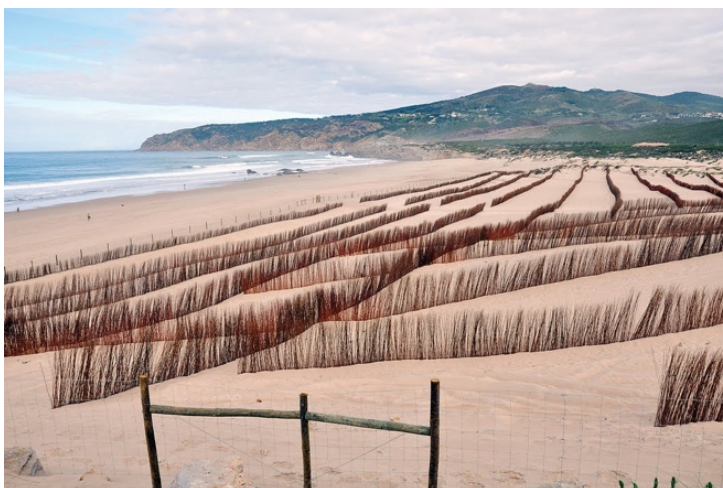
Figuras 28. Consolidação de dunas primárias na Praia do Guincho, 2010.
