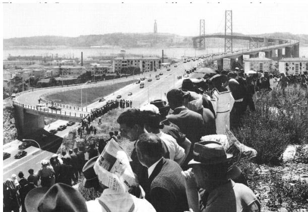
Figura 12. Inauguração da ponte Oliveira Salazar, 6 de Agosto de 1966.
