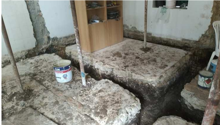
Figura 3.3 Abertura de roços e fundação caso de estudo
