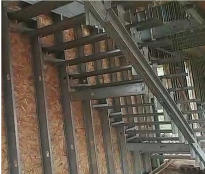
Figura 2.16 Escada apoiada a parede
