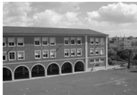
Foto nº 8: Escola secundária de Gil Vicente, Lisboa. Fonte: Parque Escolar
