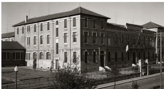
Foto nº 17: Liceu de Alexandre Herculano, Porto. Fonte: Parque Escolar
