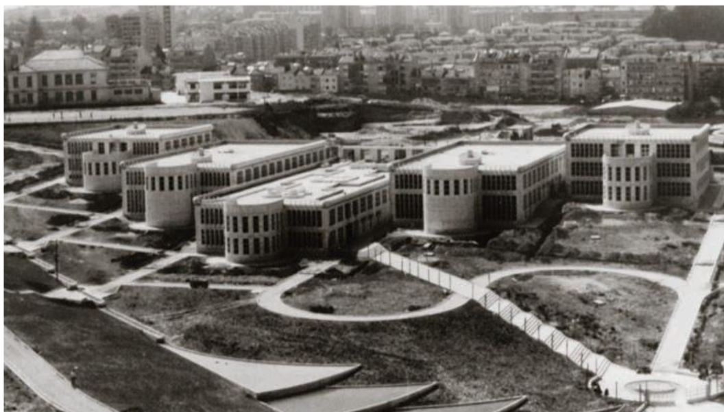
Foto nº 14: Liceu de Benfica (atual Escola Secundária de José Gomes Ferreira), Lisboa. Fonte: Parque Escolar
