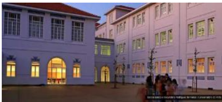
Foto nº 32: Liceu de Pedro Nunes, após requalificação da Parque Escolar, Lisboa. Fonte: Parque Escolar
