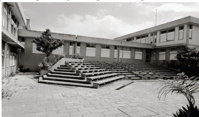
Foto nº 12: Escola Secundária de Vila Nova de Santo André (atual Escola Secundária de Padre António Macedo), Santiago do Cacém. Fonte: Parque Escolar
