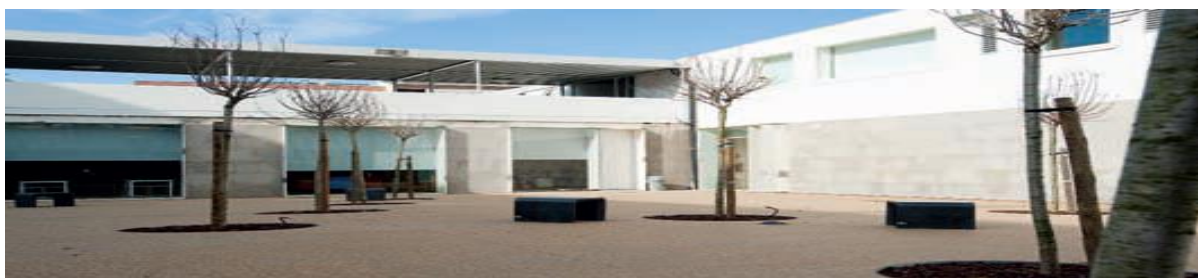
Foto nº 41: Escola Secundária de Padre António Vieira. Fonte Parque Escolar
