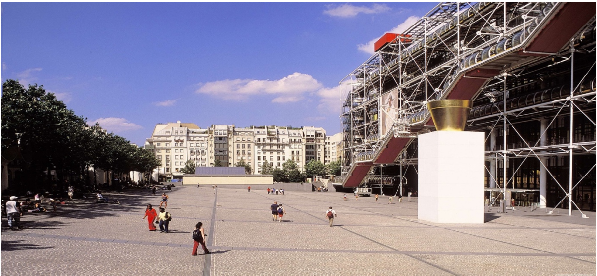
Figura 9. Praça lateral do edifício com ligeira inclinação. Fonte: https://medium.com/@thalysoprmo/centre-national-dart-et-de-culture-georges-pompidou-um-estrangeiro-naturalizado-42f7d7ba0610
