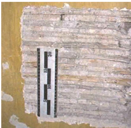
Figura 44. Parede de tabique no primeiro piso elevado fonte: Fotografia facultada pela CML. PA n.º 394/DOM-D (2007)
