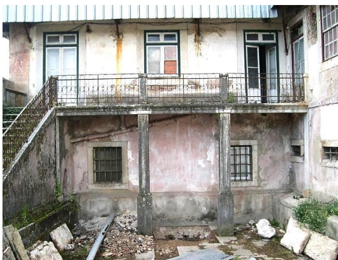
Figura 38. Fachada Posterior. Corpo primitivo fonte: Fotografia facultada pela CML. PA n.º 394/DOM (2007)
