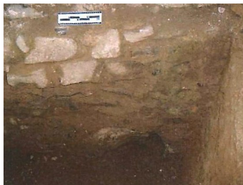
Figura 42. Sondagem de fundações-Parede fonte: Fotografia facultada pela CML. PA n.º 394/DOM (2007)
