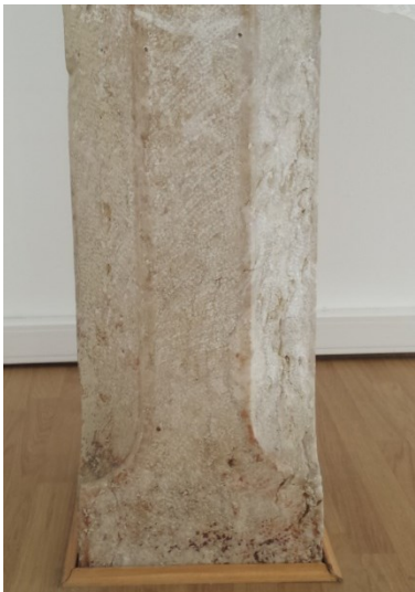
Figura 76. Coluna de pedra maciça - Vestígios de degradação fonte: Autor (2016)
