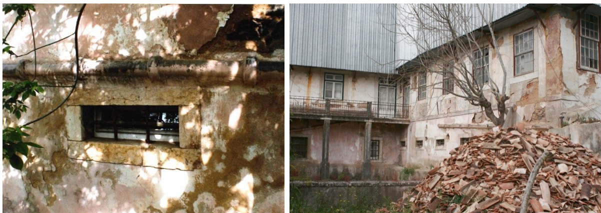
Figura 34. Detalhe da janela no piso térreo
