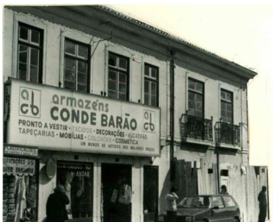
Figura 22. Edifício 4 de Outubro onde é possível verificar o uso ao nível do piso térreo fonte: Ferreira, F. M. (1986)
