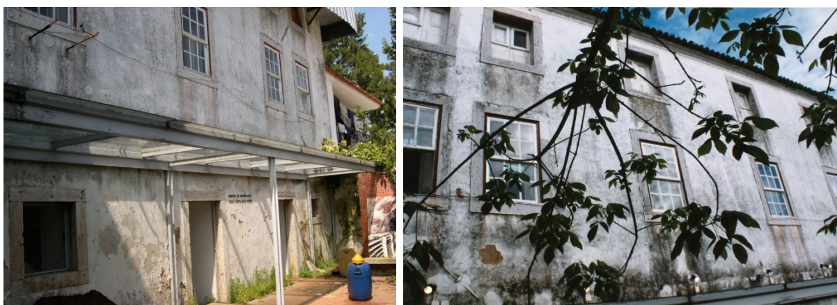
Figura 36. Segundo corpo. Fachada lateral direita-Vista inferior
