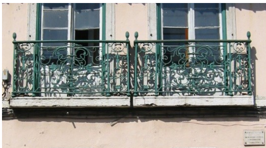
Figura 58. Varandas em cantaria e guardas em ferro fundido fonte: Autor (2015)
