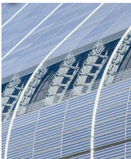
Fig. 104 – Pormenor da fachada
