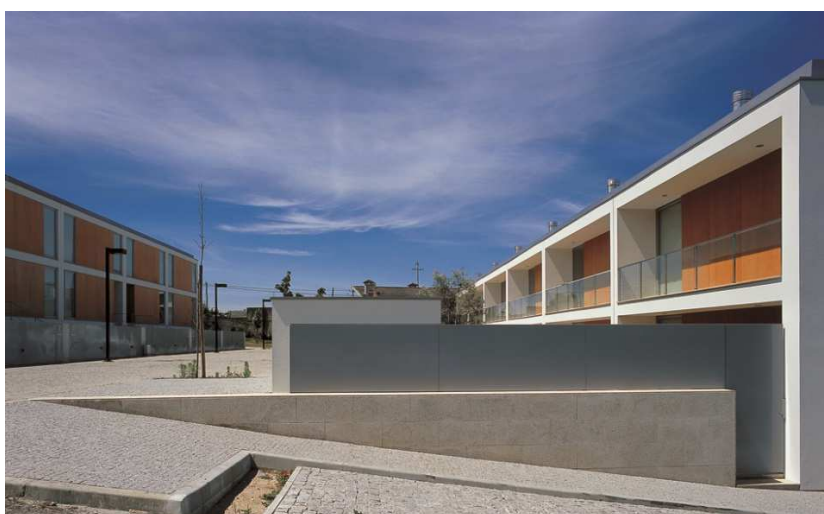
Fig. 96 – Diferente perspectiva do edifício
