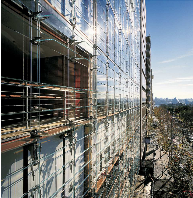
Fig. 73 – Pormenor da fachada
