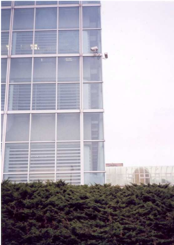
Fig. 52 – Pormenor da fachada
