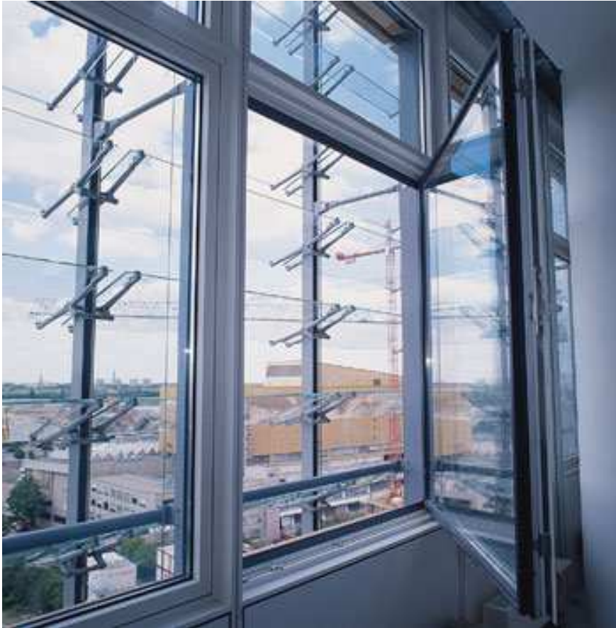
Fig. 64 – Pormenor da fachada
