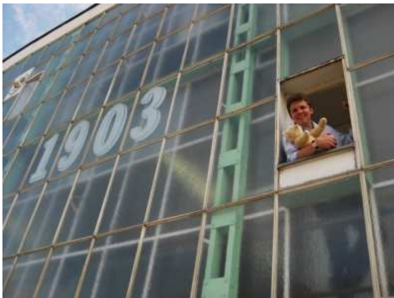
Fig. 24 – Pormenor da fachada
