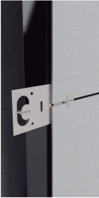
Fig. 5 – Pormenor de sistema de fixação visível
