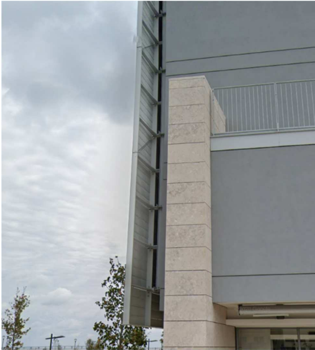
Fig. 106 – Pormenor da fachada
