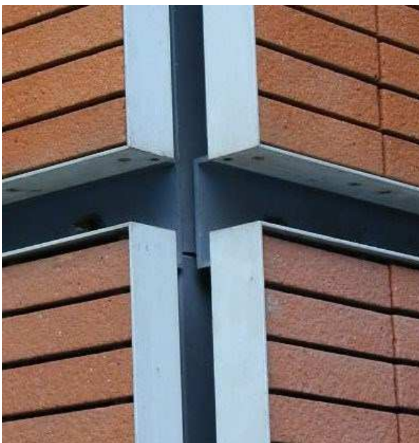
Fig. 59 – Pormenor da fachada
