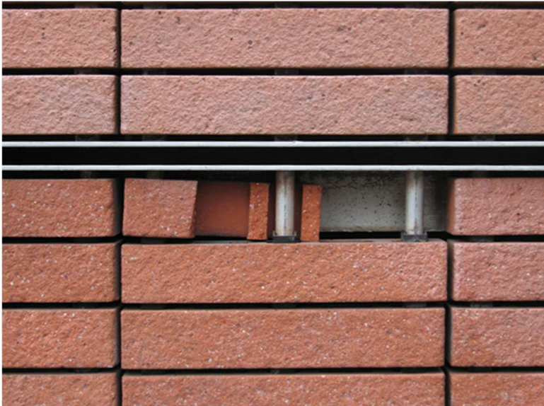
Fig. 60 – Pormenor da fachada
