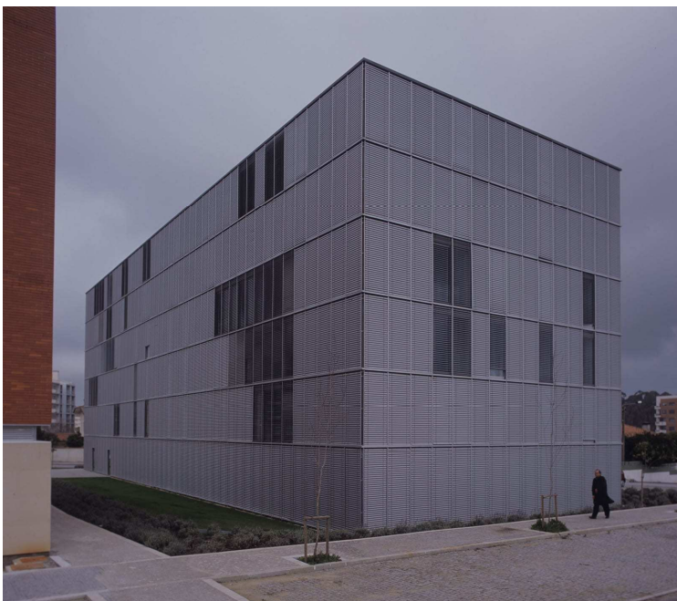
Fig. 89 – Diferente perspectiva do edifício
