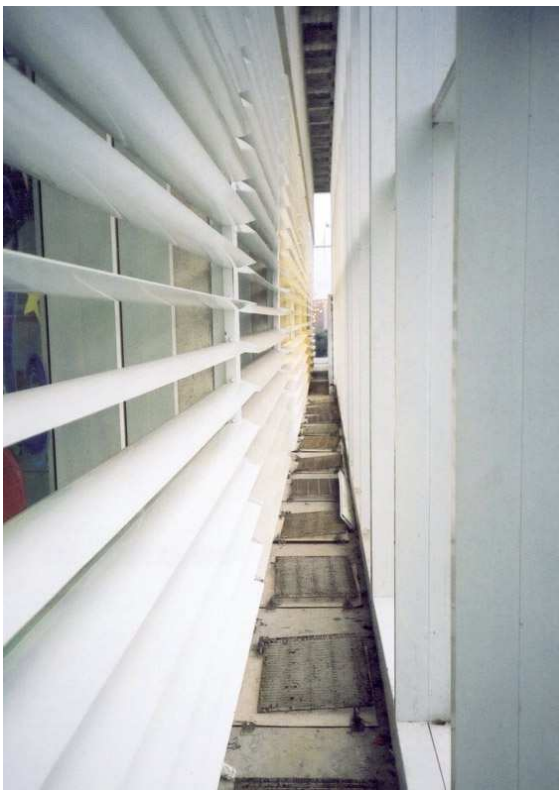
Fig. 53 – Pormenor da fachada
