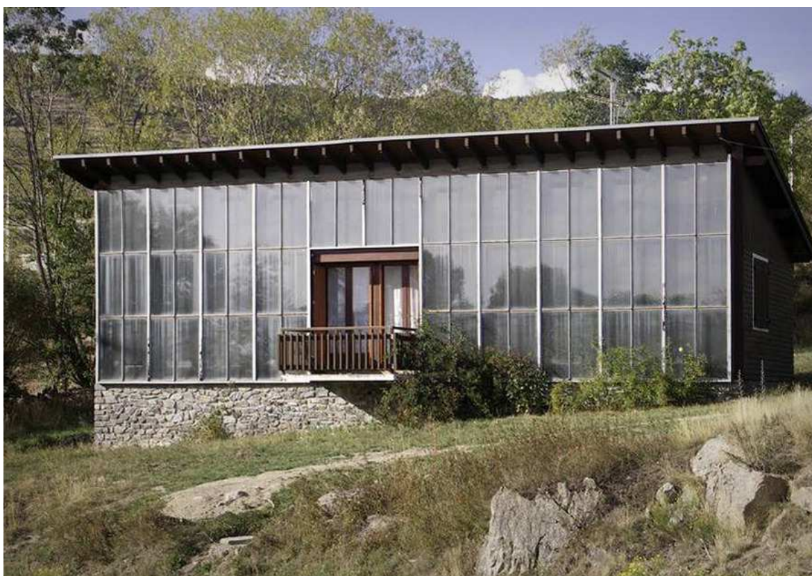
Fig. 45 – Solar House (fachada sul)
