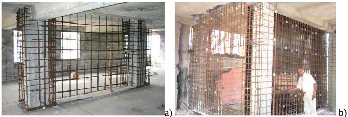
Figura 4 – Paredes resistentes de betão armado: a) (Ehsani, 2007) e b) (Singh, 2024)
