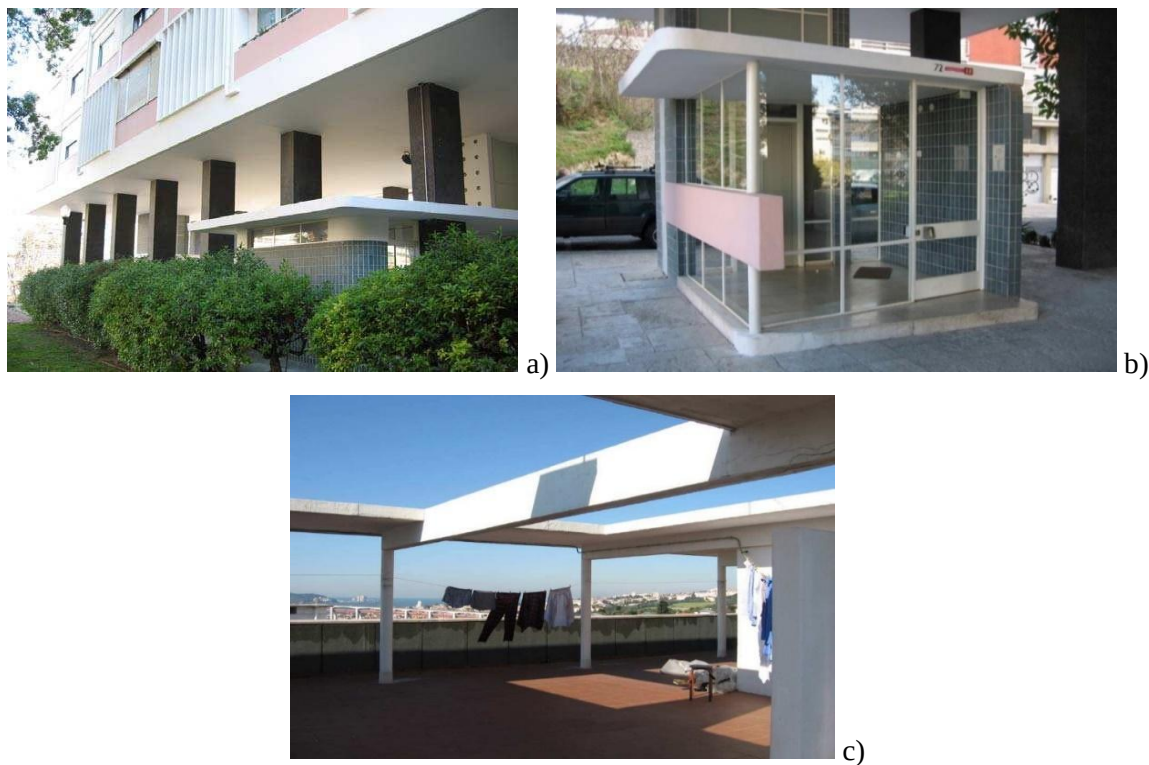
Figura 27 – Fotografias do Lote 5: a) detalhe dos pilotis (Silva, 2015); b) pormenor da entrada numa das extremidades (Rocha, 2012); c) cobertura destinada a zona de estendais (Rocha, 2012).
