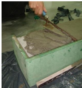
Figura 57 - Aplicação do 2º reboco
