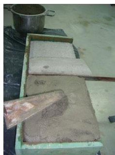
Figura 55 - Aplicação do 1º reboco
