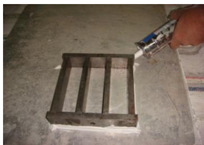
Figura 42 - Aplicação do silicone
