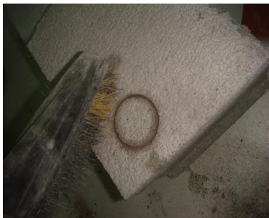
Figura 74 - Limpeza e regularização da superfície
