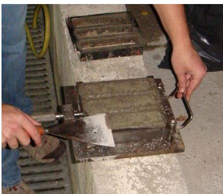
Figura 37 - Retirar o excesso da argamassa
