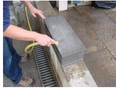
Figura 52 - Leve hidratação do bloco
