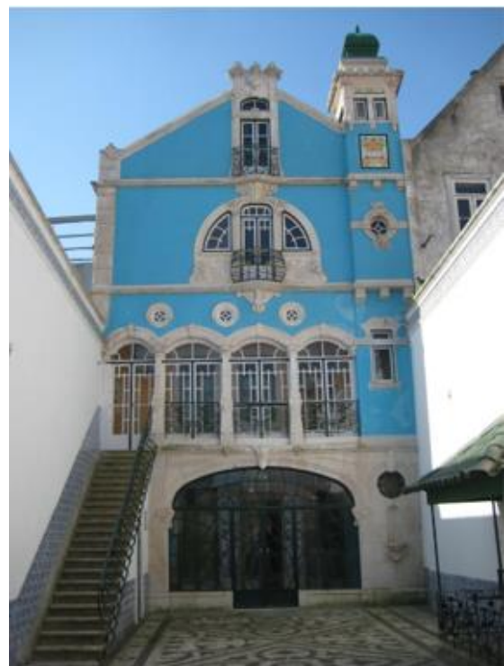
Figura 39. Casa Major Pessoa, fachada posterior depois da reabilitação
