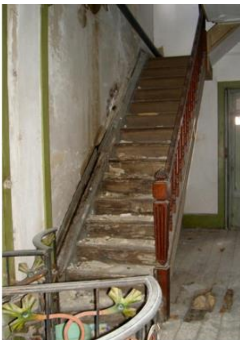
Figura 34. Casa Major Pessoa, interior antes da reabilitação
