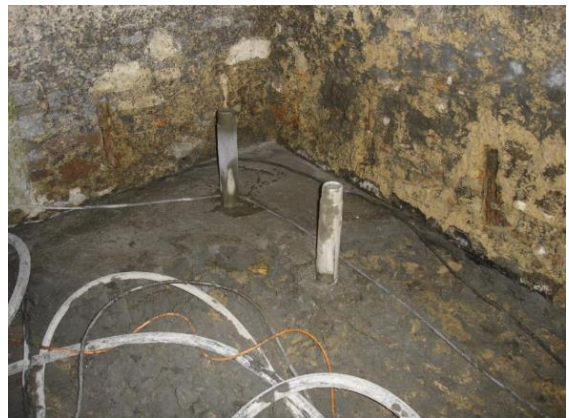
Figura 25. Casa Major Pessoa, reforço de fundações, micro estacas
