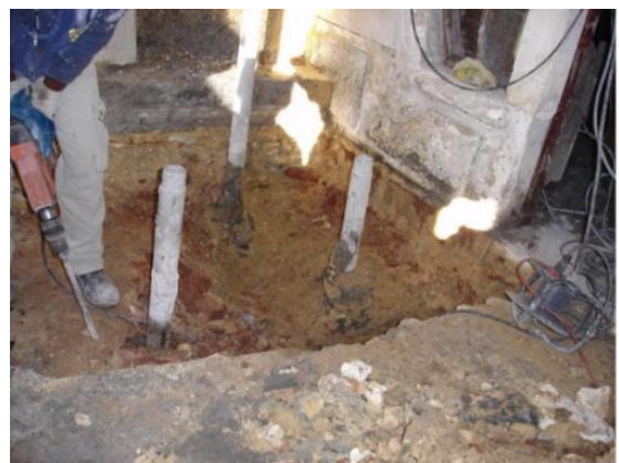
Figura 27. Casa Major Pessoa, reforço de fundações, micro estacas
