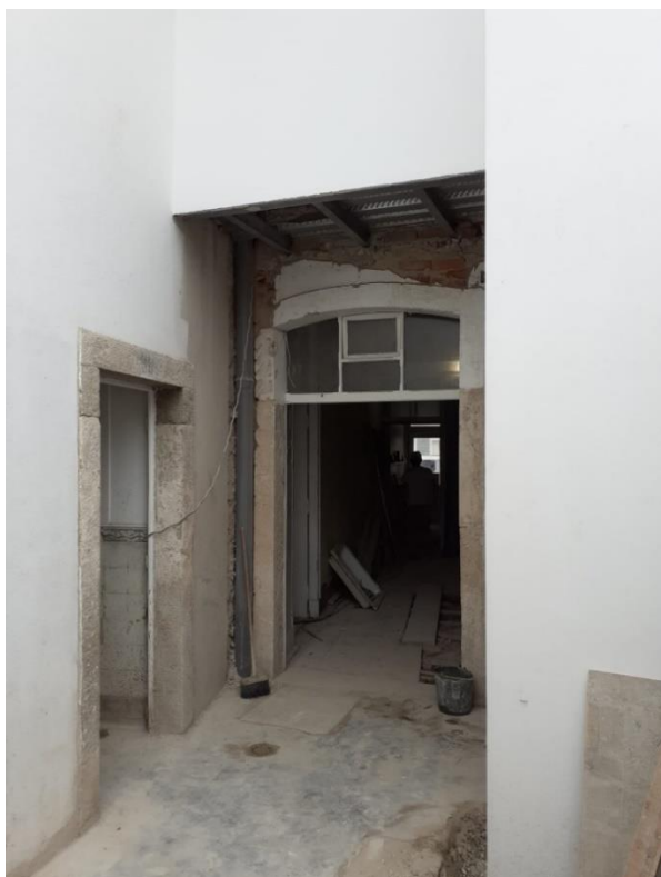
Figura 51. Edifício do Largo Dr. José Barbosa durante a reabilitação, pormenor do arco
