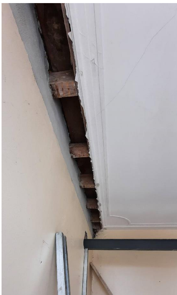
Figura 100. Largo Dr. José Barbosa, preparação para a colocação da cantoneira de ferro
