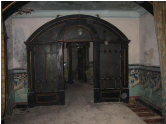
Figura 32. Casa Major Pessoa, interior antes da reabilitação
