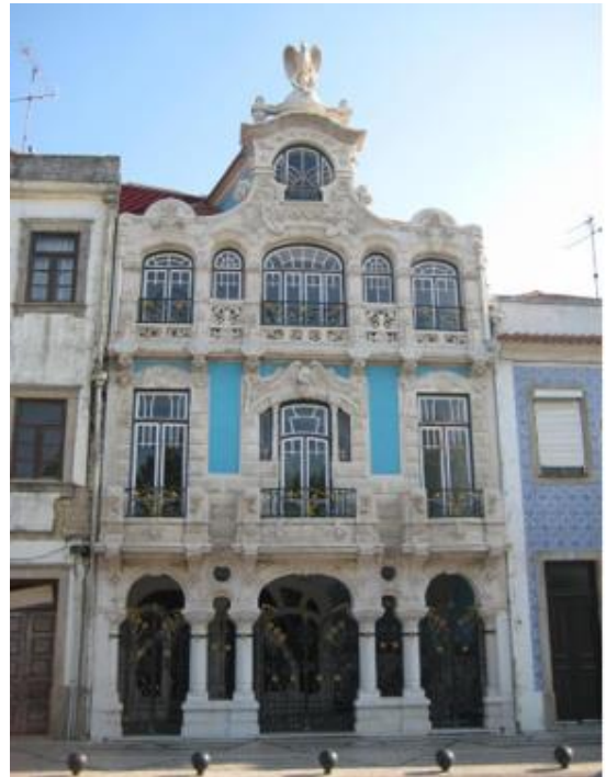
Figura 37. Casa Major Pessoa, fachada principal depois da reabilitação
