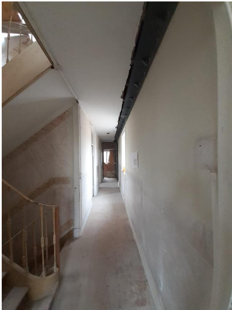
Figura 109. Edf. Largo Dr. José Barbosa, pormenor da sanca de ferro de suporte passagem da nova rede de eletricidade e ited
