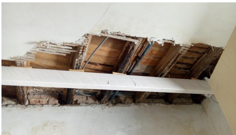
Figura 63 e 64. Edf. Largo Dr. José Barbosa, prumo de suporte de piso em colapso
