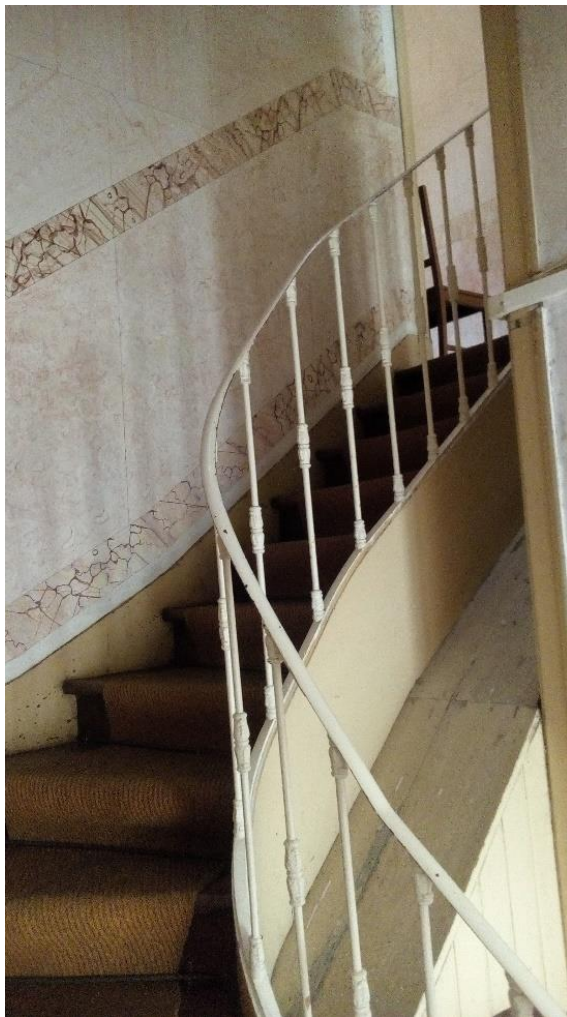
Figura 76. Edf. Largo Dr. José Barbosa, estada interior antes da intervenção
