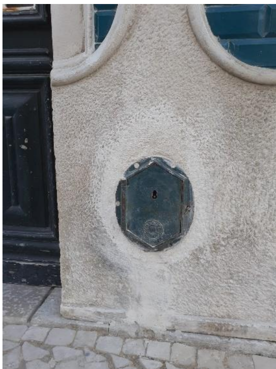
Figura 48. Largo José Barbosa, ligação de água da rede pública ao edifício
