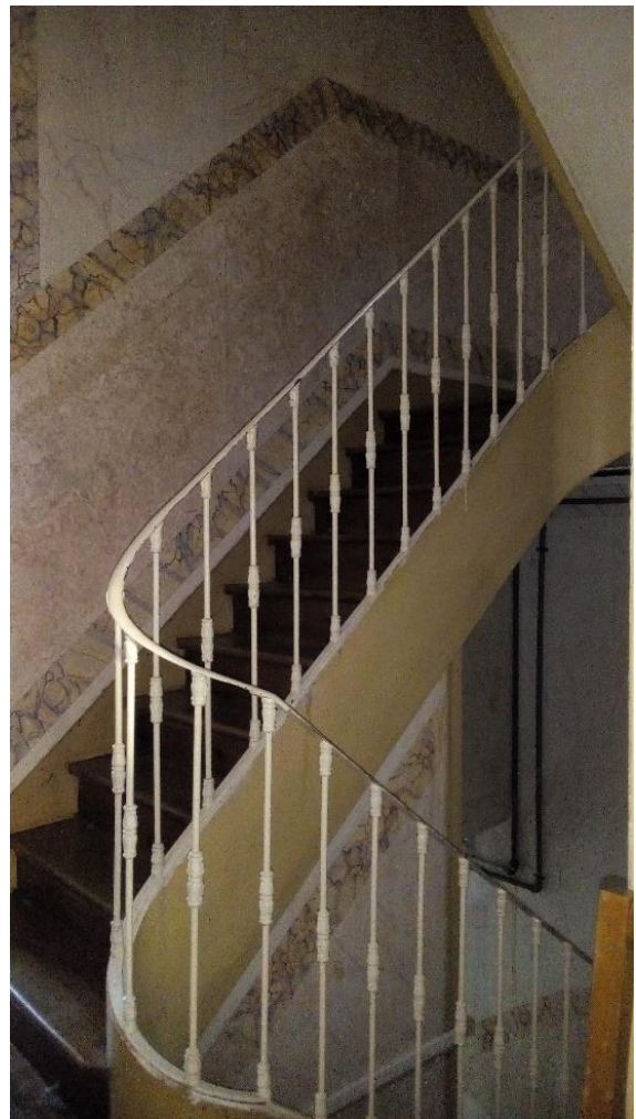
Figura 77. Edf. Largo Dr. José Barbosa, estada interior antes da intervenção
