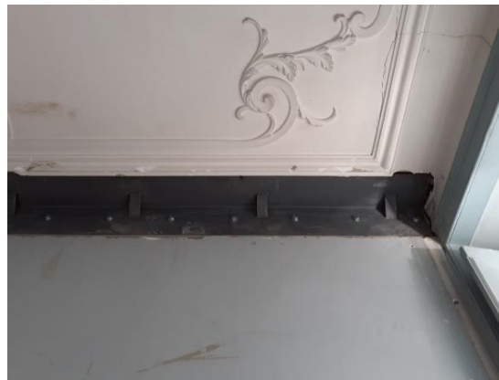
Figura 102. Edf. Largo Dr. José Barbosa, cantoneira de ferro de suporte das vigas
