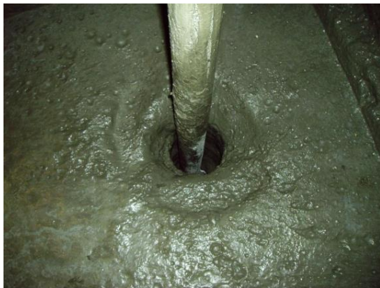
Figura 24. Casa Major Pessoa, reforço de fundações, micro estacas
