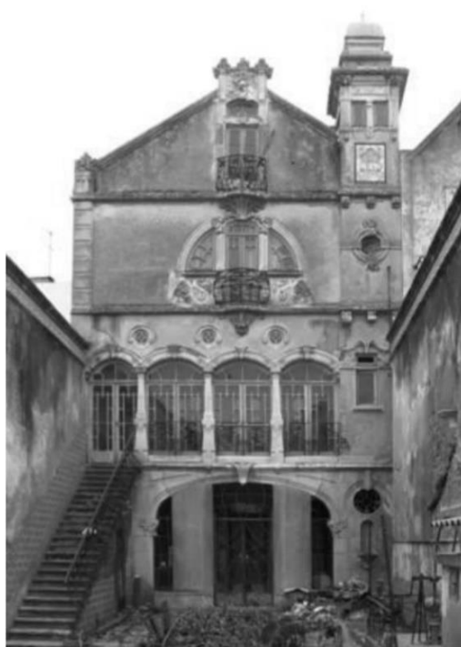
Figura 18. Casa Major Pessoa, fachada posterior
