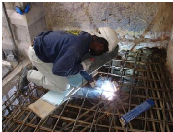
Figura 26. Casa Major Pessoa, reforço de fundações, maciço de encabeçamento
