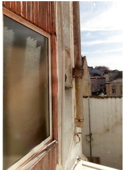
Figura 54. Edf. Largo D José Barbosa, fachada tardoz antes da reabilitação
