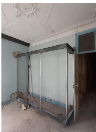
Figura 89. Edf. Largo Dr. José Barbosa, caixa autoportante da casa de banho
