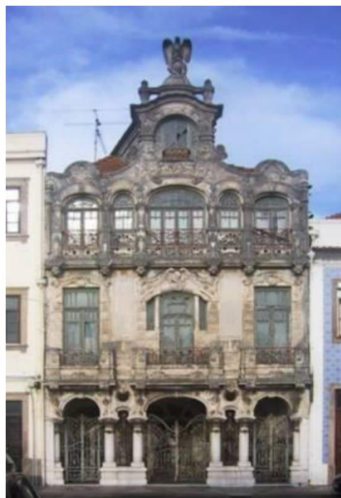
Figura 17. Casa Major Pessoa, fachada principal
