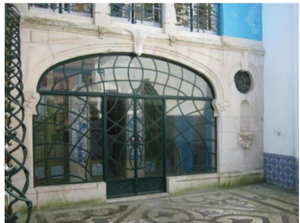
Figura 31. Casa Major Pessoa, fachada posterior depois da reabilitação
