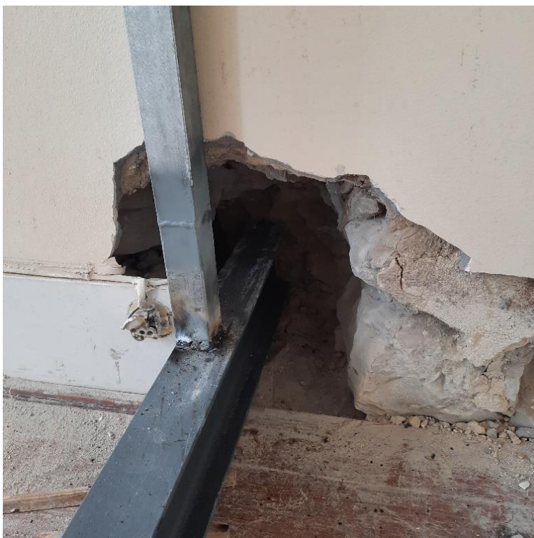
Figura 92. Edf. Largo Dr. José Barbosa, pormenor da fixação da caixa autoportante da casa de banho
