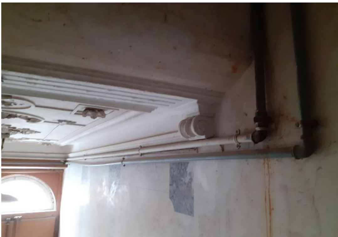
107.Edf. Largo Dr. José Barbosa, tubagem de águas a remover
