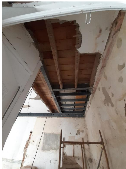
Figura 106. Edf. Largo Dr. José Barbosa, colocação das novas vigas de madeira
