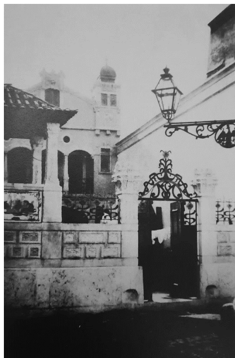
Figura 19. Casa Major Pessoa, fachada posterior em 1907
