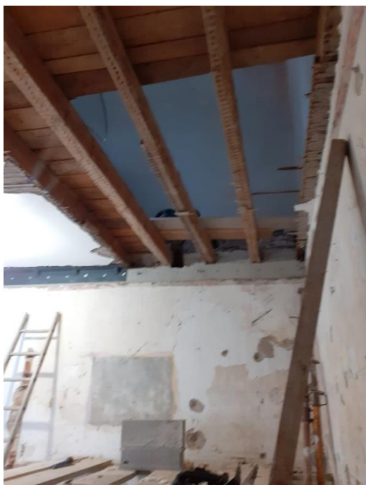
Figura 105. Edf. Largo Dr. José Barbosa, colocação das novas vigas de madeira
