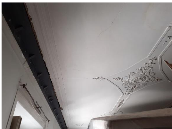
Figura 101. Edf. Largo Dr. José Barbosa, cantoneira de ferro de suporte das vigas
