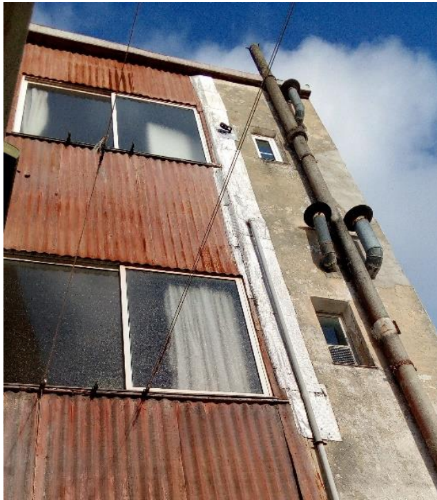
Figura 53. Edf. Largo D José Barbosa, fachada tardoz antes da reabilitação “varandas”
