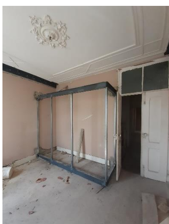
Figura 90. Edf. Largo Dr. José Barbosa, caixa autoportante da casa de banho
