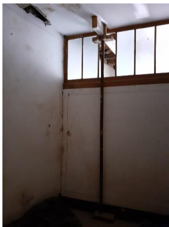
Figura 63 e 64. Edf. Largo Dr. José Barbosa, prumo de suporte de piso em colapso
