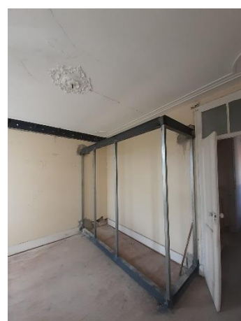
Figura 91. Edf. Largo Dr. José Barbosa, caixa autoportante da casa de banho
