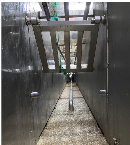
Figura 11 – Rampa de acesso ao equipamento de imobilização. Original do autor.
