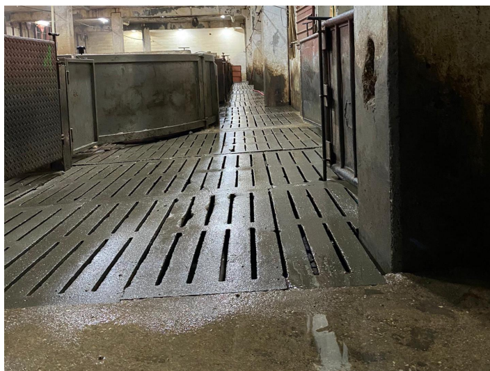
Figura 10 – Corredor principal. Original do autor.
