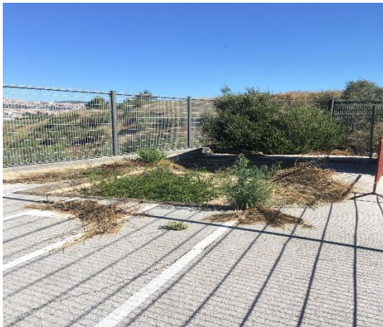
Figura 28 - Caixa de areia
