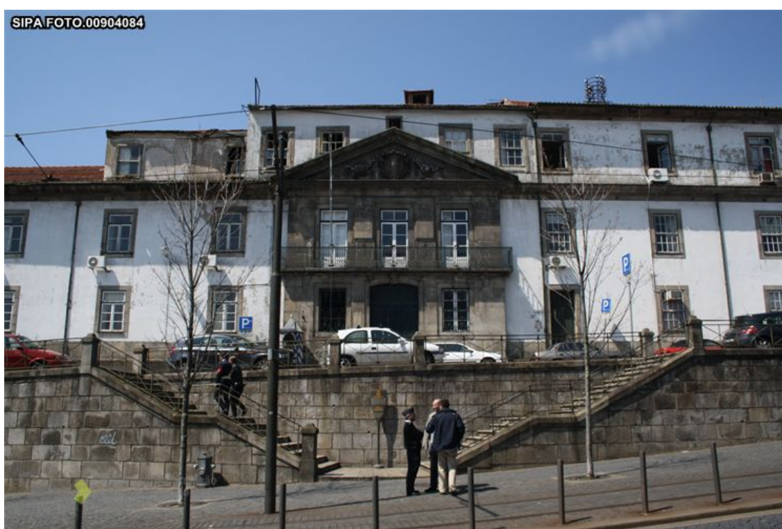
Figura 9 Entrada principal do edifício do Governo Civil do Porto
