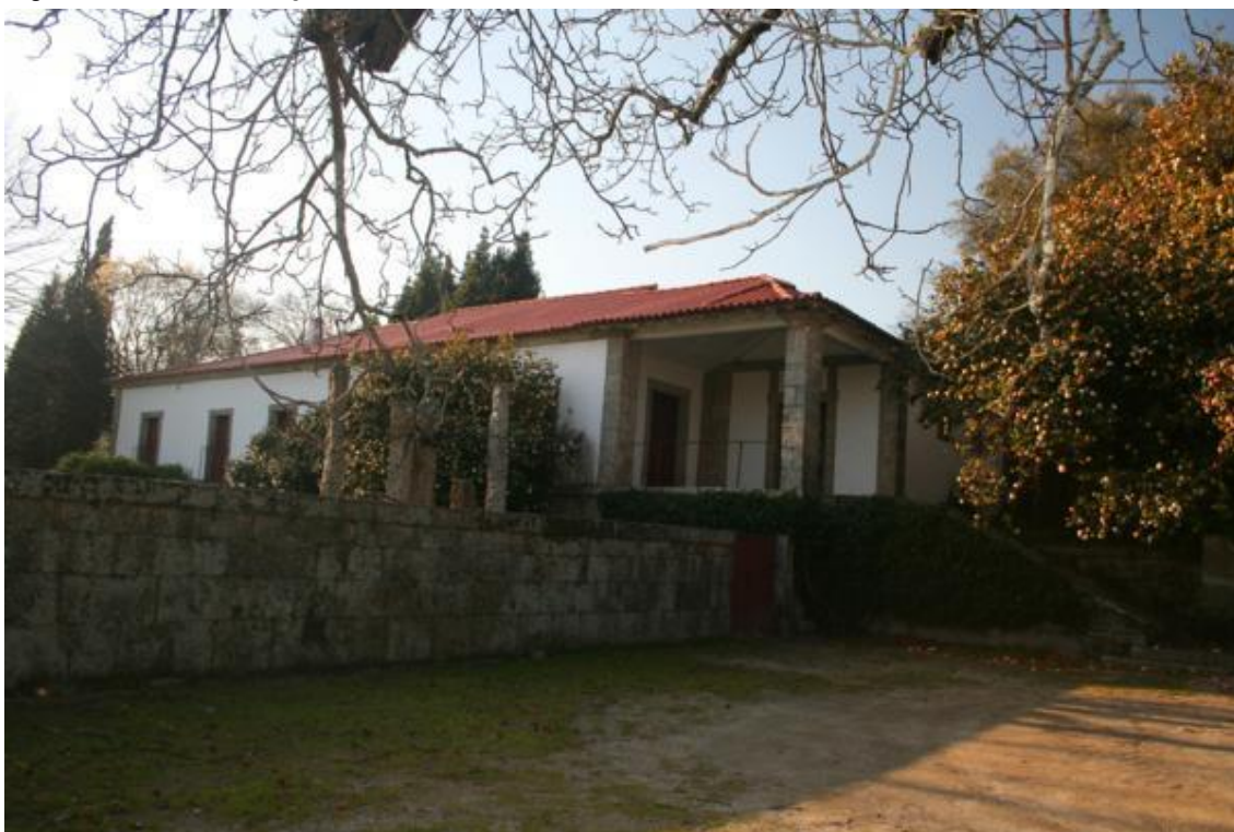
Figura 32 - Alçado principal casa da Covilhã
