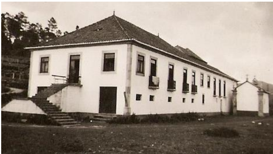
Figura 6 - Alçado Oeste casa de Alvelo, fotografia início séc. XX
