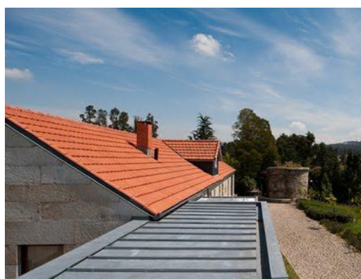
Figura 58 – Pormenor do telhado
