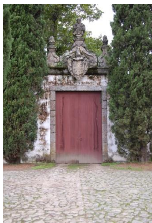
Figura 33 - Portão casa da Covilhã
