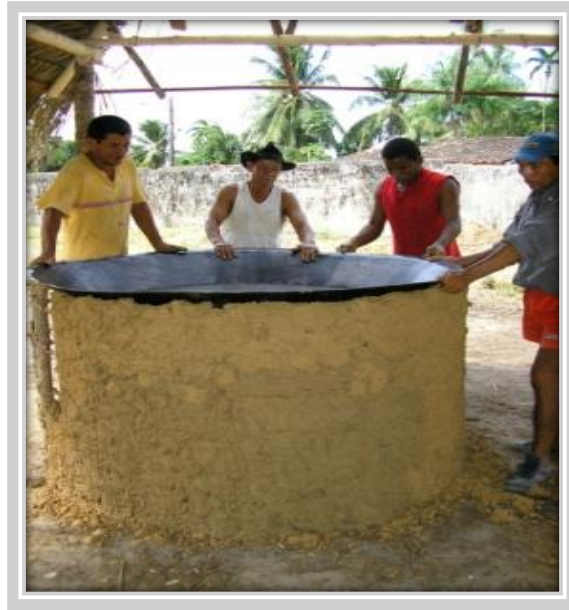
Fotografia 34: Mutirão da construção da casa de farinha e seu forno. Fonte: Arquivo EXPOEC, 2007.
