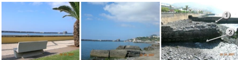
6. Depois do muro a surpresa: a decadência da foz das ribeiras de João Gomes (1) e de Santa Luzia (2).
