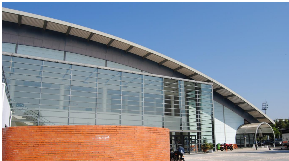
Fotografia 10 - Alçado Sul/Entrada Piscinas EUL, Fonte: Autor
