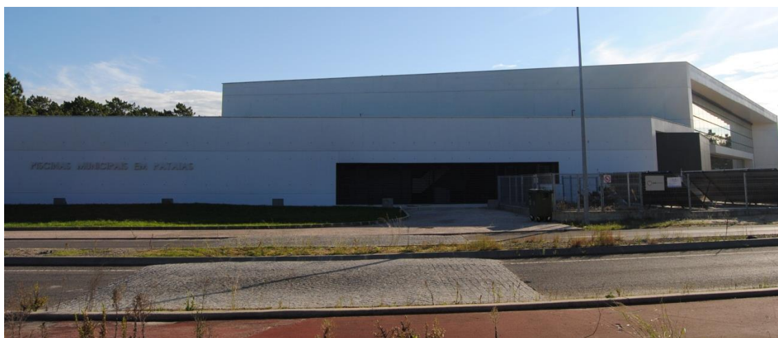
Fotografias 25 e 26 - Fachada Principal e Fachada Poente Piscinas Municipais de Pataias, Fonte: Autor
