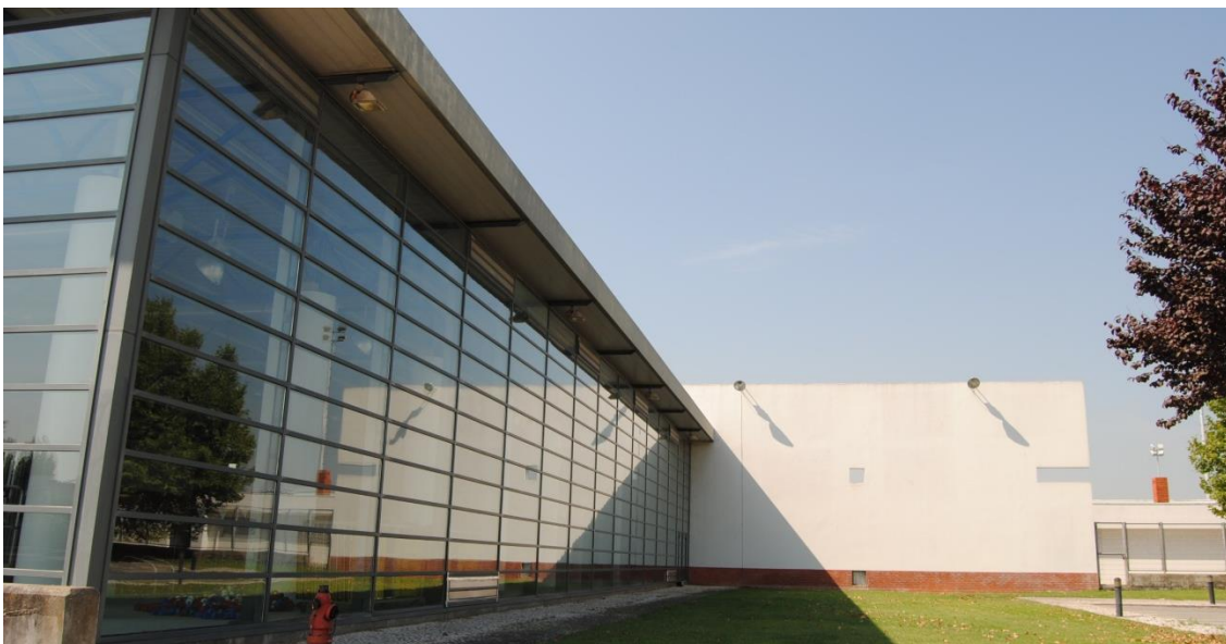
Fotografia 13 - Alçado Norte Piscinas EUL, Fonte: Autor
