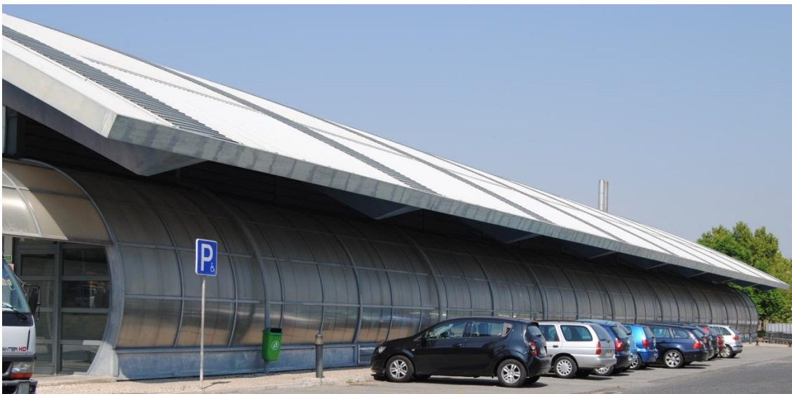
Fotografia 12 - Alçado Nascente Piscinas EUL, Fonte: Autor
