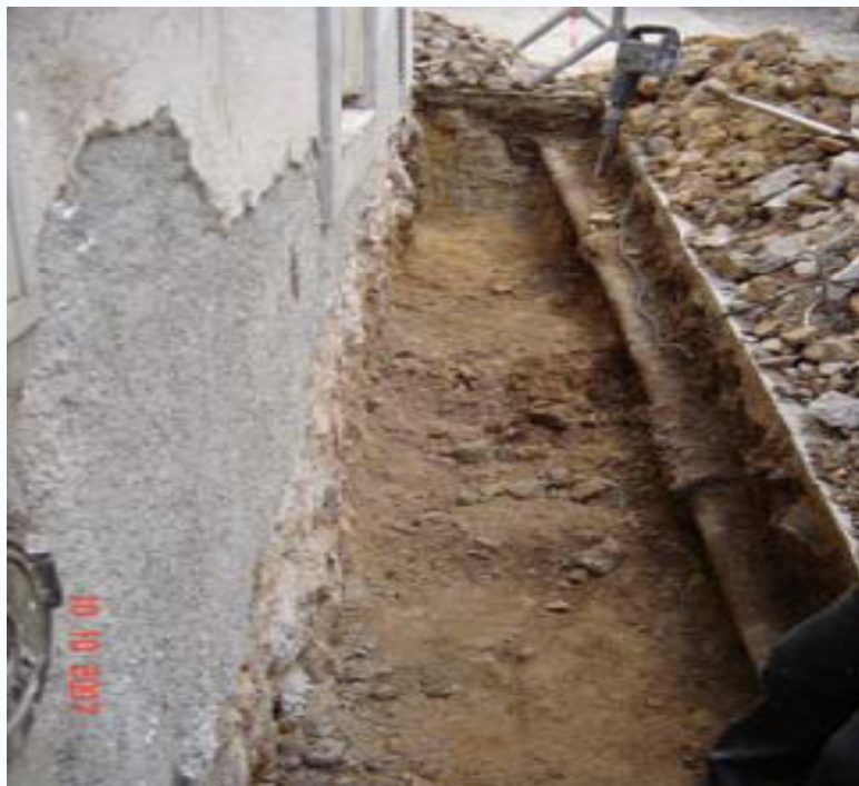
Fig.36 Execução de vala para construção de drenagem periférica do edifício para evitar a subida de humidade nas paredes por capilaridade.
