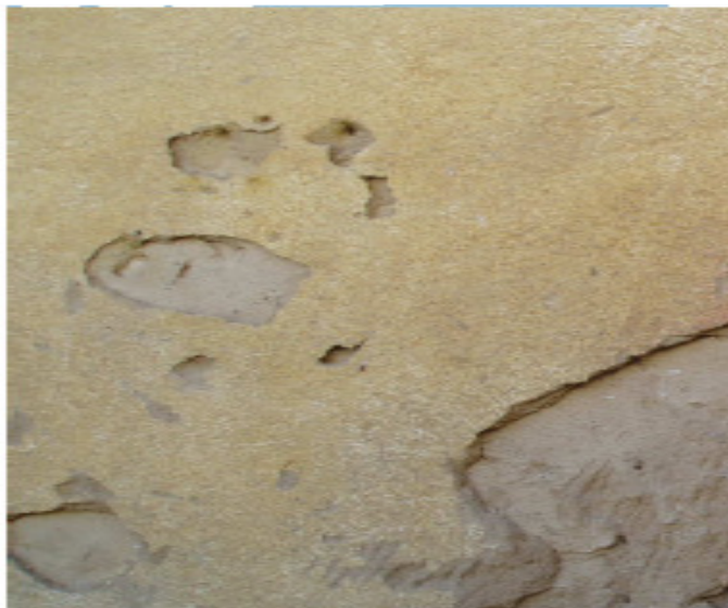
Fig.52 Revestimento em parede com três camadas. Foto do autor.
