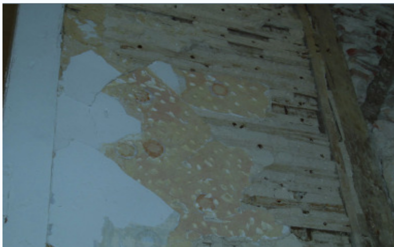
Fig.53 Picagem da superfície para melhor aderência.
