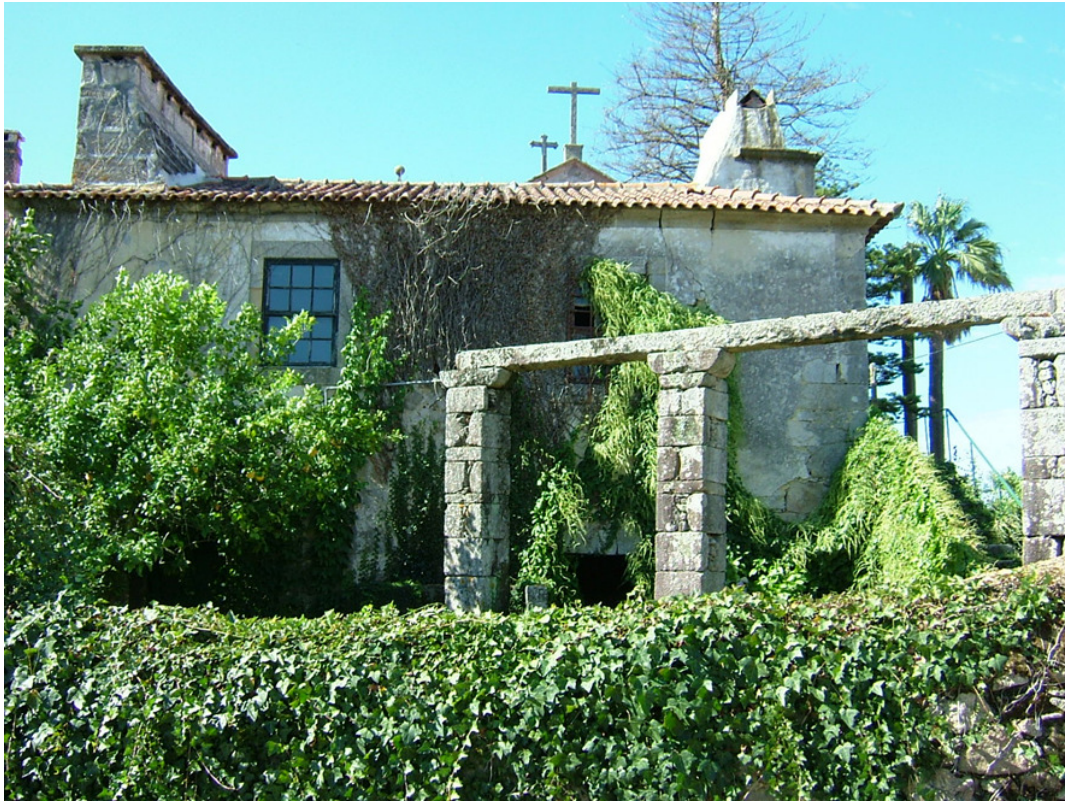
Foto 9 – Alçado Lateral Esquerdo (parte)
