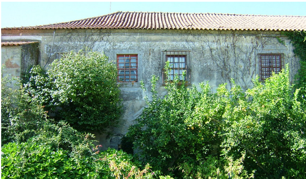
Foto 8 -Alçado Lateral Esquerdo (parte)
