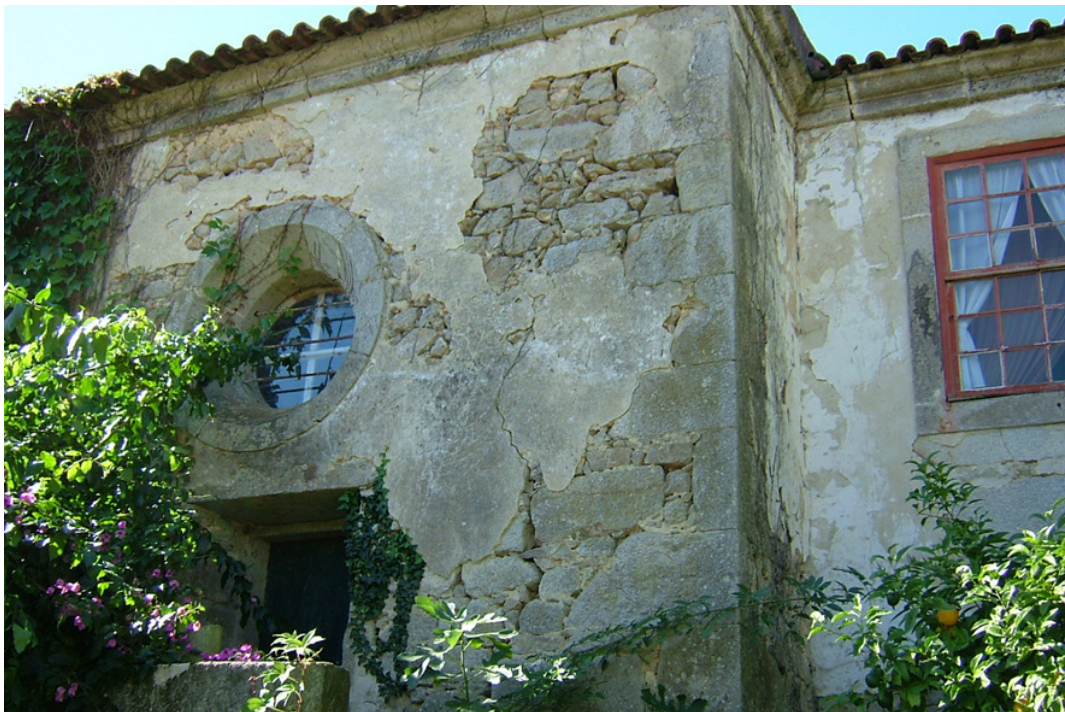
Foto 10 – Alçado Lateral Esquerdo (parte)
