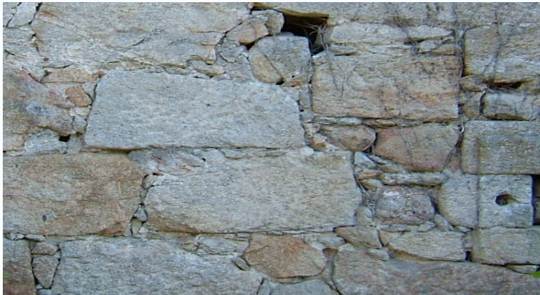
Fig.49 Junta Aberta. Foto do autor
