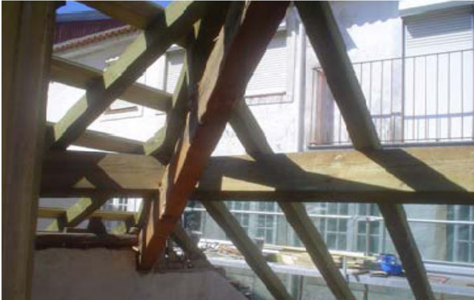
Fig.18 Estrutura da cobertura em madeira. Preocupação na utilização dos materiais originais.
