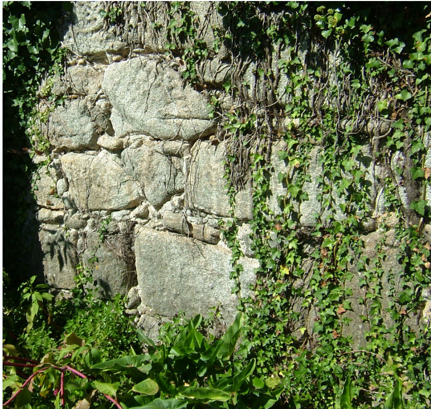
Fig.38 As raízes das plantas são agentes biológicos que contribuem para a degradação das alvenarias. Foto do autor.
