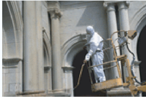
Fig.57 Pulverização de solução contendo bactérias biomineralizadas «consolidante».
