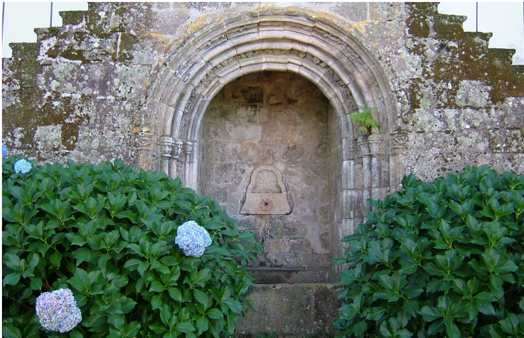
Foto 3 – Fontanário situado no vão das escadas
