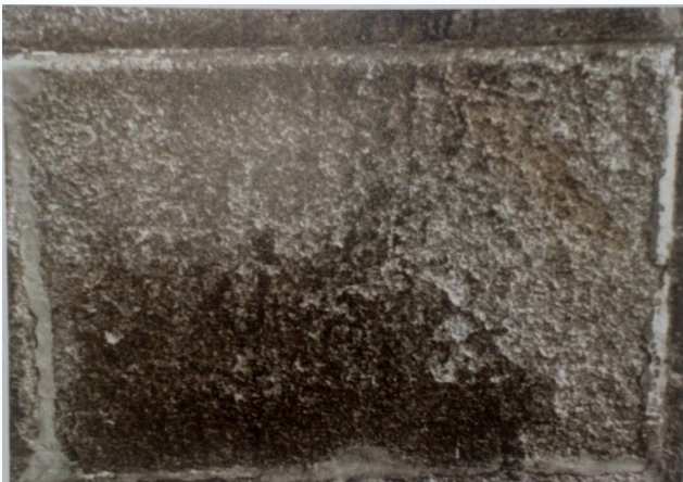
Fig.44 Escamação ou descamação.
