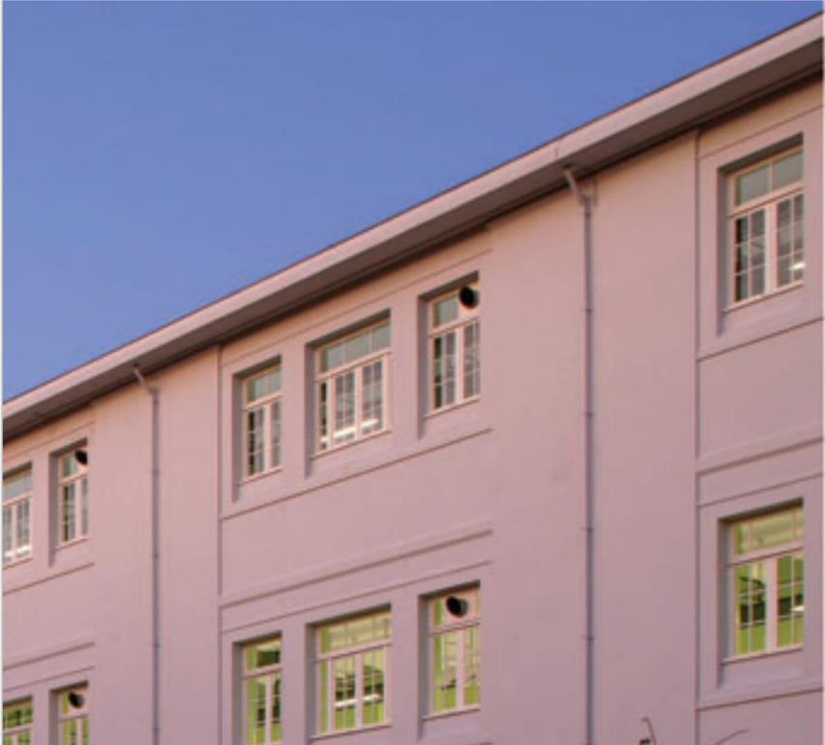
Figura 55 – Detalhe de fotografia da fachada da Escola com as condutas de extração de ar à mostra nas janelas. Fonte: (Heitor, 2011).
