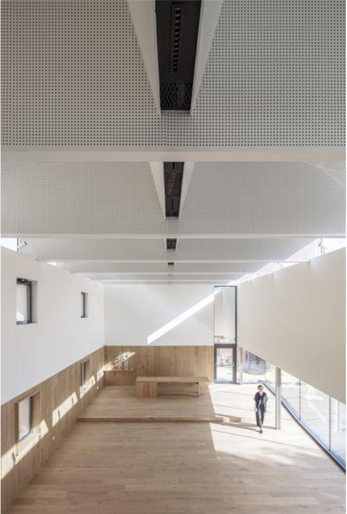
Figura 42 – Exemplo de teto parcialmente rebaixado para ocultação de condutas. Pabellón de ladrillo en dos tiempos - Estúdio Gonzales Arquitectos. Fonte: (Chicano A. M., 2022, p. 24)
