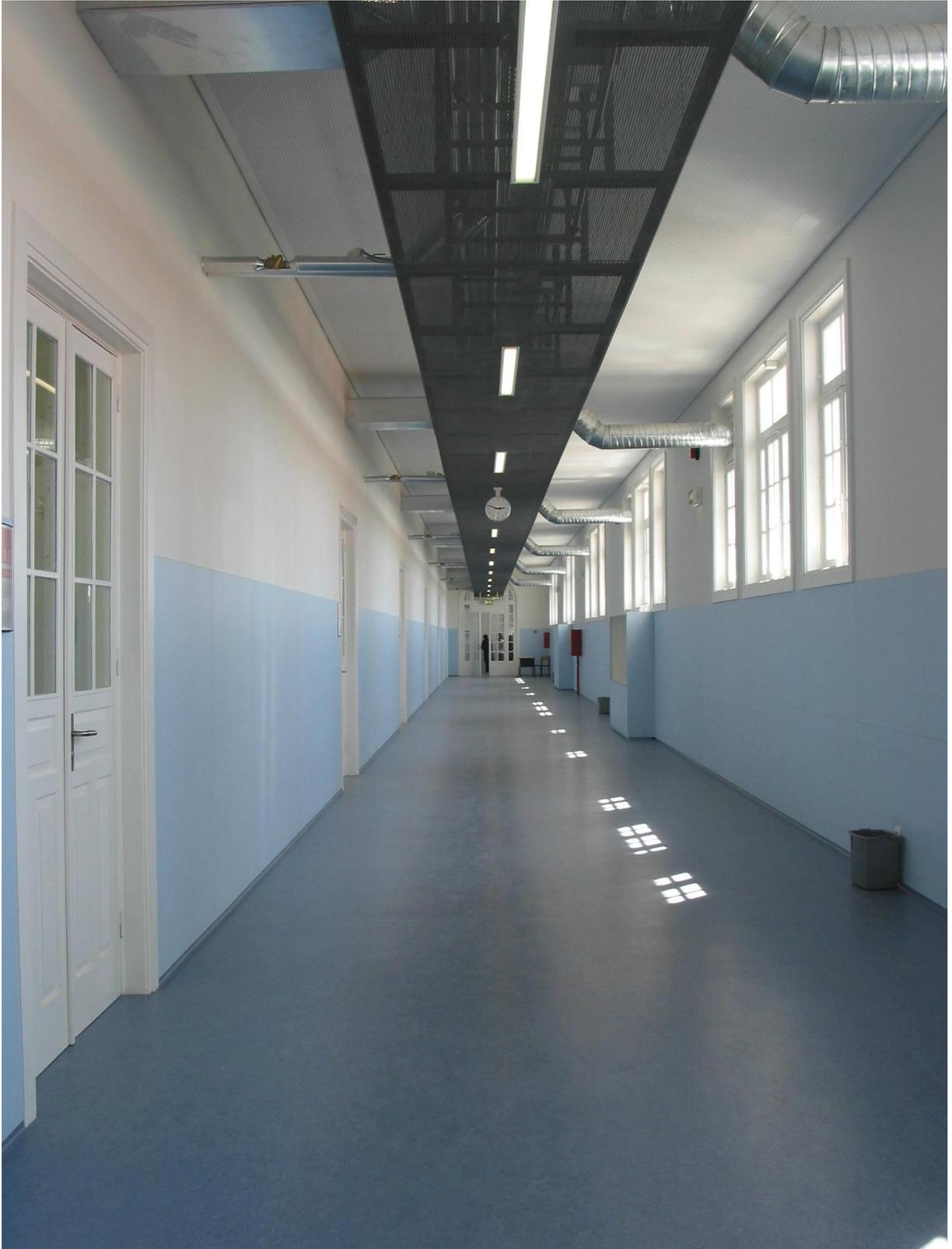
*Figura 54 – Imagem do corredor com a esteira técnica para passagem das infraestruturas e estruturas de AVAC.
