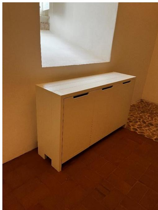
Figura 44 – Sistema de ocultação de sistemas de AVAC em equipamento de mobiliário - *Montebelo Mosteiro de Alcobaça - Fotos do autor.*
