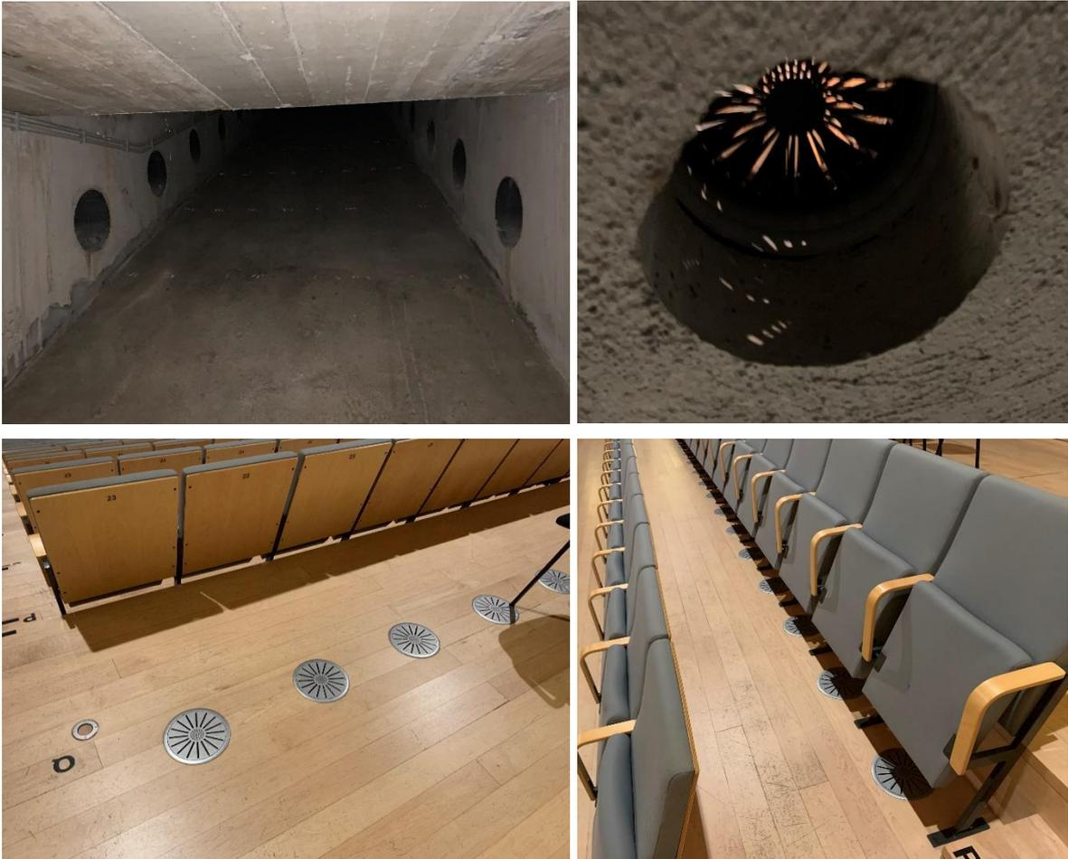
Figura 19 – Modelo de sistema de difusão por deslocamento. Da esquerda para a direita: 1) túnel de deslocamento de ar com tubos de abastecimento nas laterais; 2) grelha de saída de ar na parte superior do túnel e com saída pelo piso acima; 3) grelhas de saída de ar no piso d auditório; 4) grelhas de saída semicultas no piso sob os assentos. Auditório da Escola Secundária Quinta das Flores – Conservatório de Música de Coimbra, Arquiteto José Paulo dos Santos. Fotos do autor.
