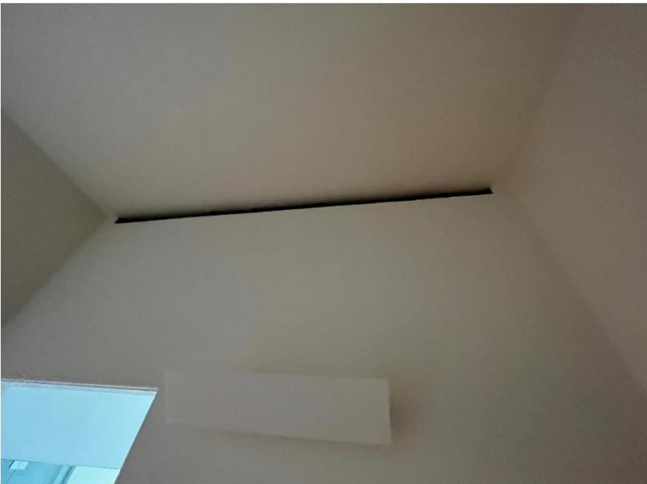
*Figura 47 – Sistema de ocultação de sistemas de AVAC nas paredes - Montebelo Mosteiro de Alcobaça - Foto do autor.*
