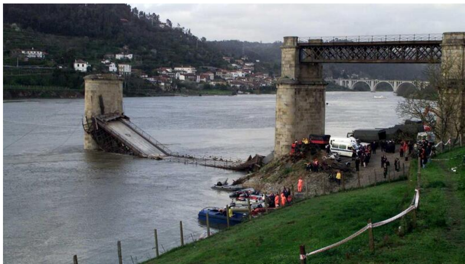
Figura 1.4 Colapso ponte sobre o rio Douro (Diário de Notícias, 2021)
