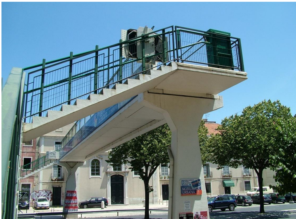
Figura 3.2 Passagem pedonal do Campo Grande
